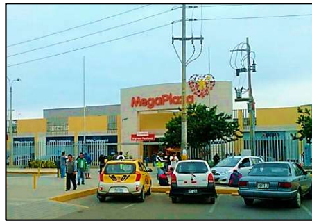
Centro Comercial Mega plaza Fuente: Google Maps
