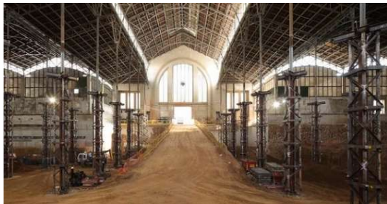
Remodelación del mercado Ninot Fuente: .
