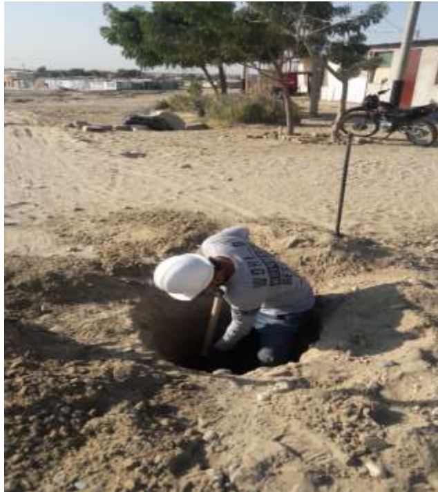
Fotografía 48. Excavación de Calicatas.
