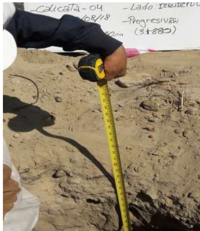
Fotografía 51. Calicata a 1.50 metros de Profundidad.
