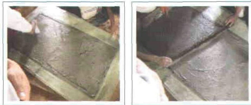
Figura 7. Se agrega la segunda capa de mezcla.
