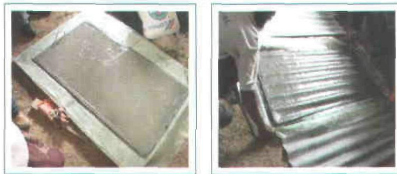
Figura 8. Se deja fraguar y se coloca sobre el 5 min.
