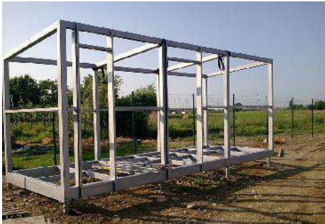
ESTRUCTURA DE ACERO
