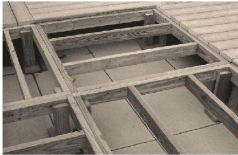
ESTRUCTURA DE MADERA
