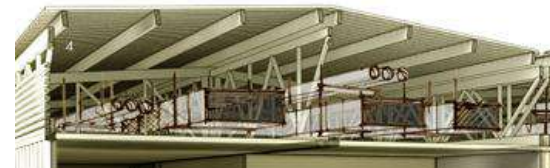
Atillos de instalaciones al interior del cielorraso
