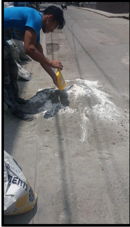
Figura 20: Evidencia 17 (Preparación de la mezcla con sika 1 en polvo)
