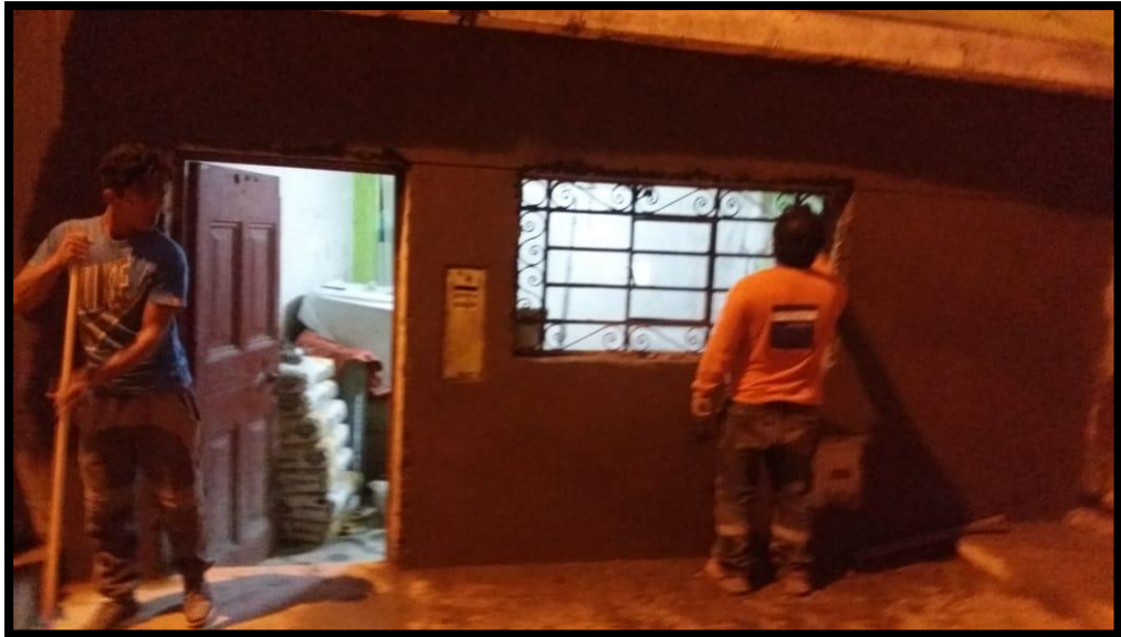
Figura 23: Evidencia 20 (Fin del tarrajeo impermeable)
