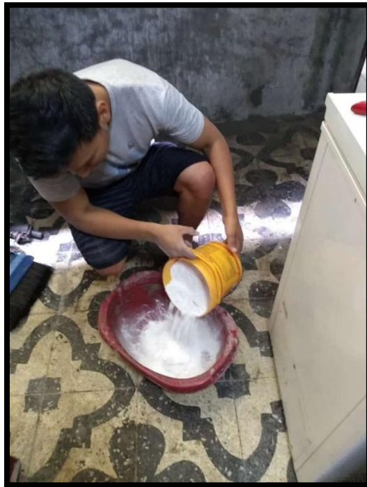
Figura 12: Evidencia 9 (Preparación del sellador sikatop)
