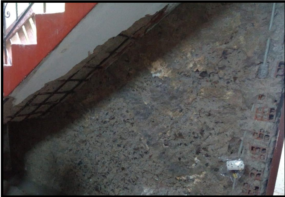
Figura 7: Evidencia 4 (Picado de tarrajeo)
