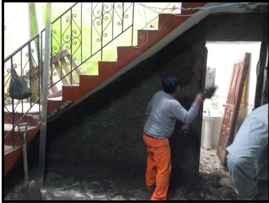
Figura 10: Evidencia 7 (Inicio de tarrajeo impermeable)
