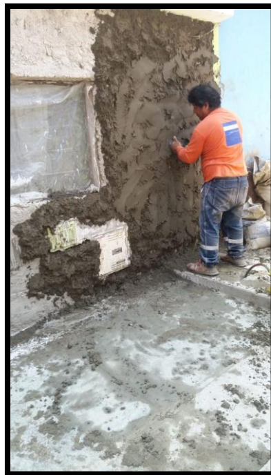
Figura 20: Evidencia 17 (Preparación de la mezcla con sika 1 en polvo)
