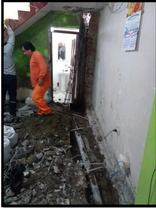
Figura 6: Evidencia 3 (Cambio de Instalación Sanitaria Dañada)
