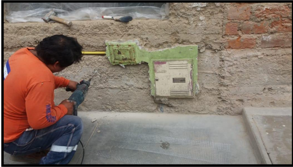
Figura 18: Evidencia 15 (Perforación de agujeros con taladro percutor)
