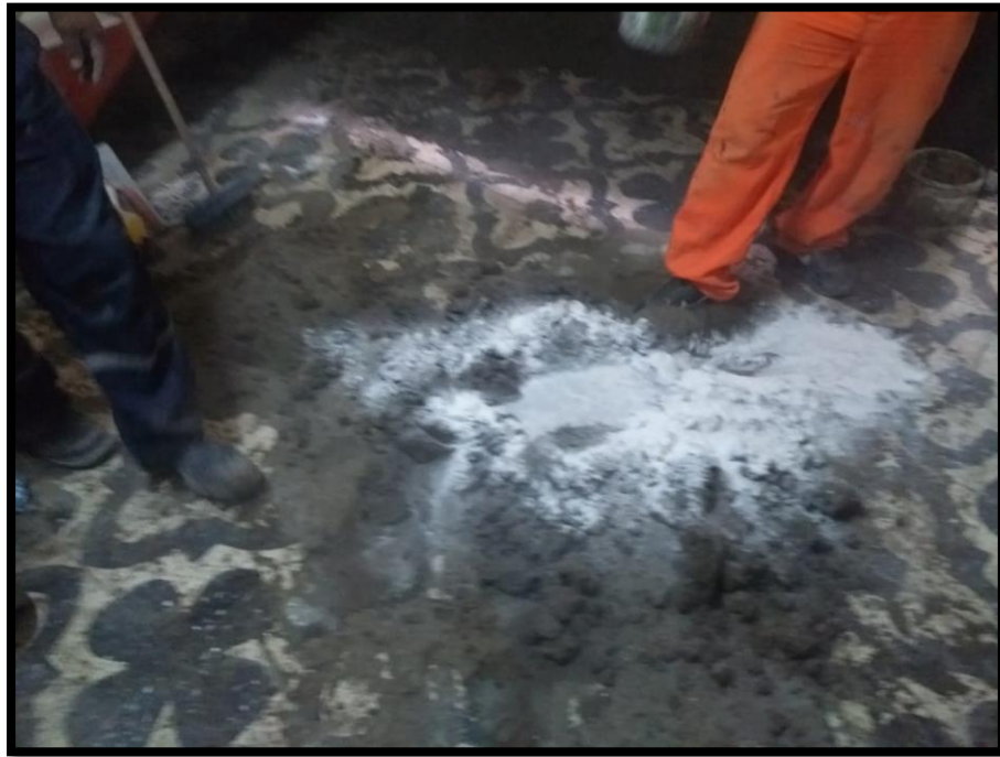
Figura 8: Evidencia 5 (Preparación del mortero agregando el sika 1 en polvo)
