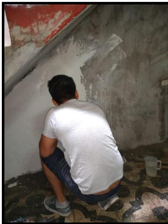
Figura 13: Evidencia 10 (Aplicación del sikatop 1)
