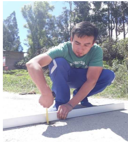
FOTO N° 02: Falla "Baches" UM 07; PROG 00+210; SEVERIDAD BAJO
