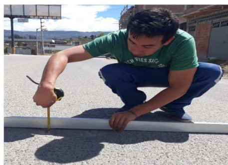
FOTO N° 09: Falla "Baches"; UM 56; PROG 01+925 SEVERIDAD BAJO
