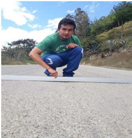
FOTO N° 19: Falla "Ahuellamiento"; UM 109; PROG 03+780; SEVERIDAD BAJO
