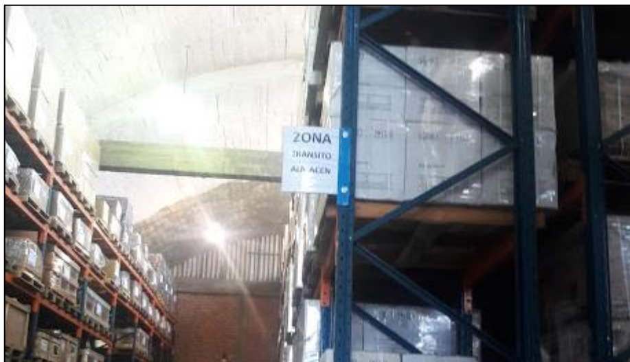
Figura N° 48: Pegado de señalizaciones 2 Fuente: Elaboración propia
