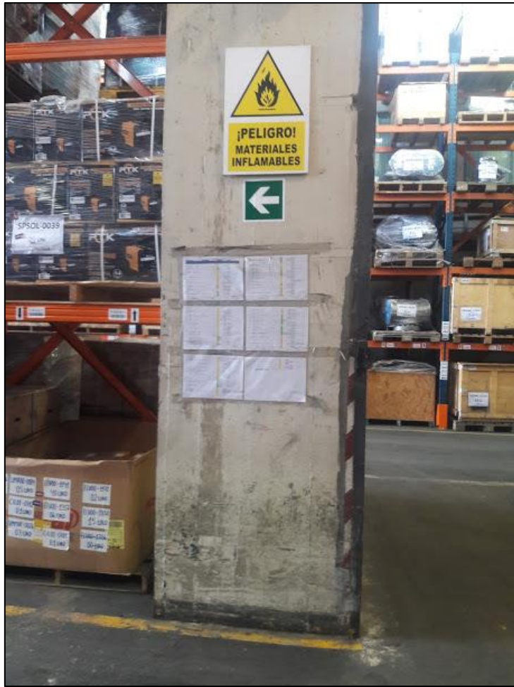
Figura N° 47: Pegado de señalizaciones 2 Fuente: Elaboración propia
