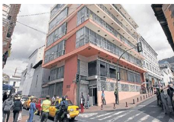
Figura 6. El edificio de la Dirección Provincial de Salud antes de su demolición. Recuperado de: Fuentes (2019)
