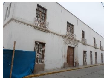
Figura 16. Casa Muga 2019 Fuente propia.
