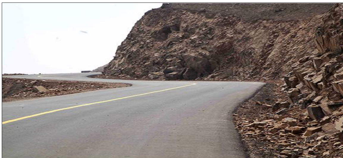
Figura 14. Anillo vial anexo 22 a anexo 8 – distrito San Antonio (2018).
