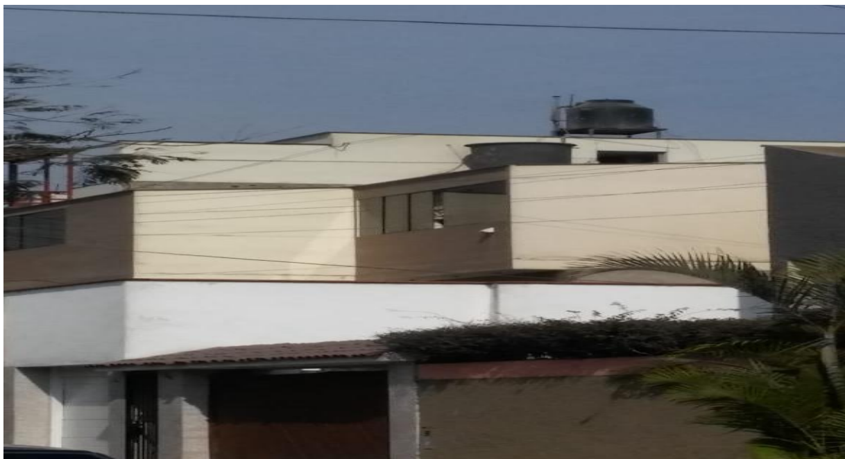
NUEVAS INSTALACIONES DE AGUA PARA VIVIENDAS QUE AHORA SON MULTIFAMILIARES
