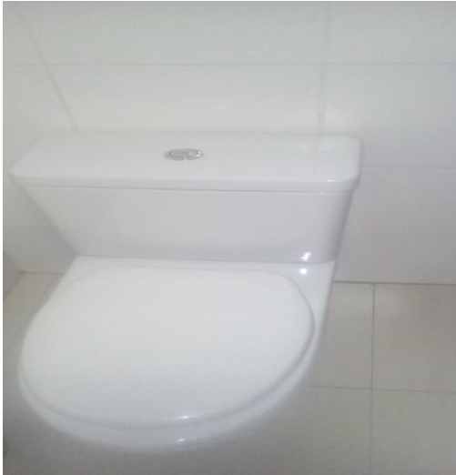
Inodoro nuevo instalado
