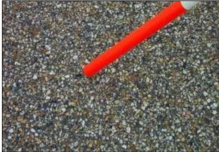
Figura 27. Agregados pulidos, no hay niveles de severidad.
