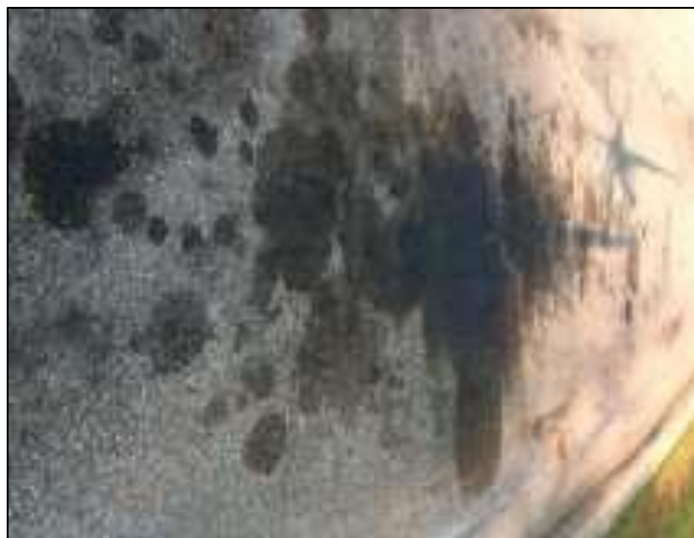
Figura 24. Derrame de combustible, no hay severidad definida.
