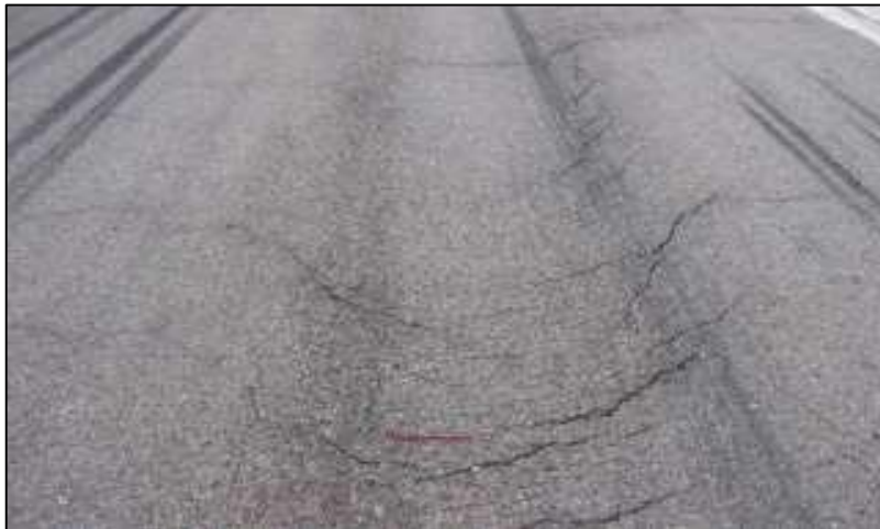
Figura 34. Desplazamiento de severidad media.
