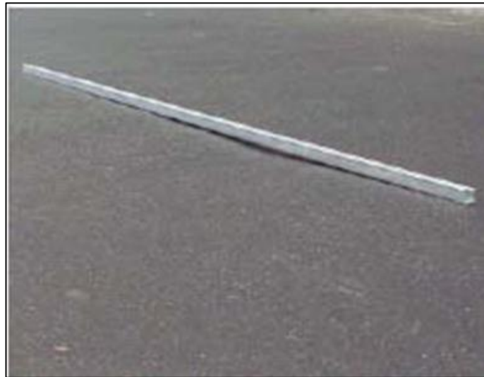
Figura 13. Ondulación de severidad media.
