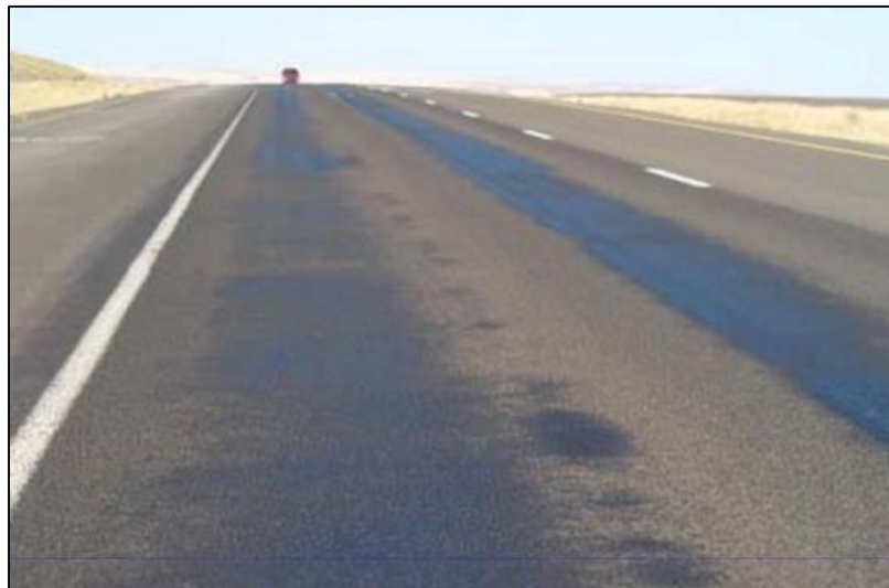
Figura 7. Exudación de severidad media.
