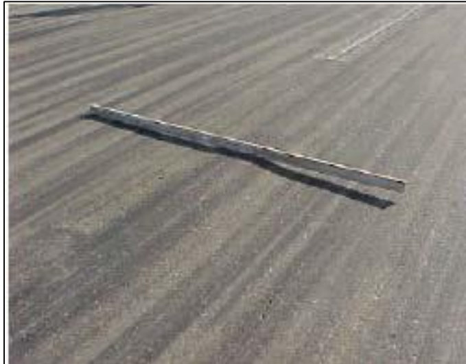
Figura 31. Ahuellamiento de severidad media.
