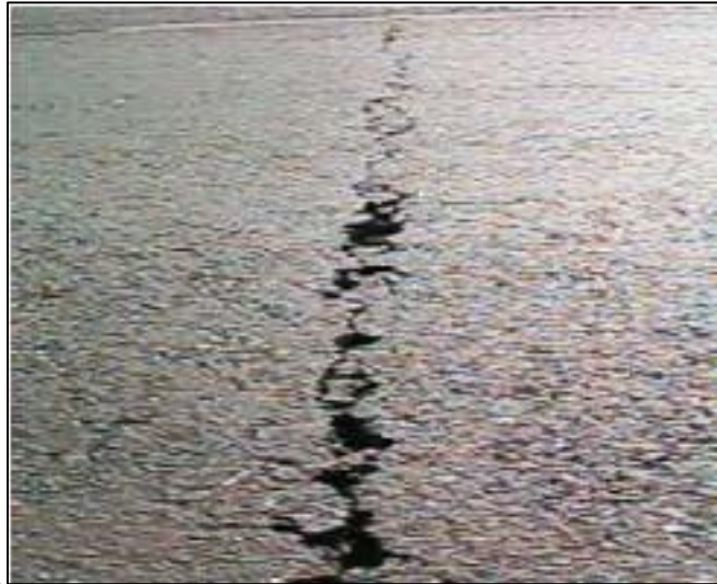
Figura 21. Reflexión de juntas de severidad alta.
