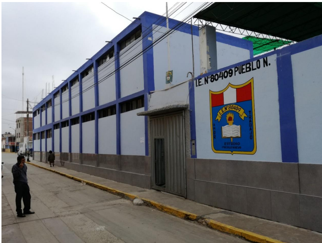
Foto 2: Vista parcial de la fachada de la I.E 80409 Pueblo Nuevo distrito de Chepén
