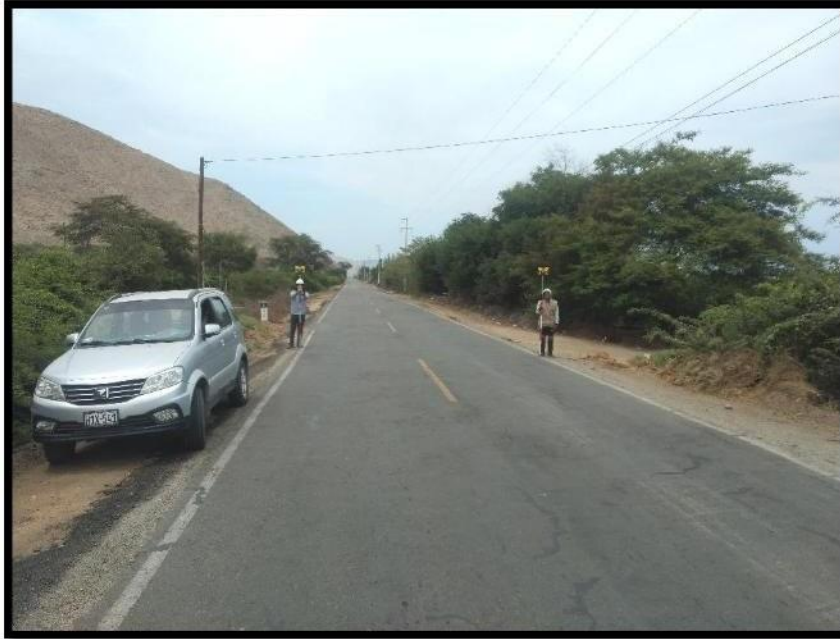
Foto: 03- SE OBSERVA A LOS ASISTENTES TOPOGRAFICOS REALIZANDO LA TOMA DE PUNTOS DE LA CARRETERA
