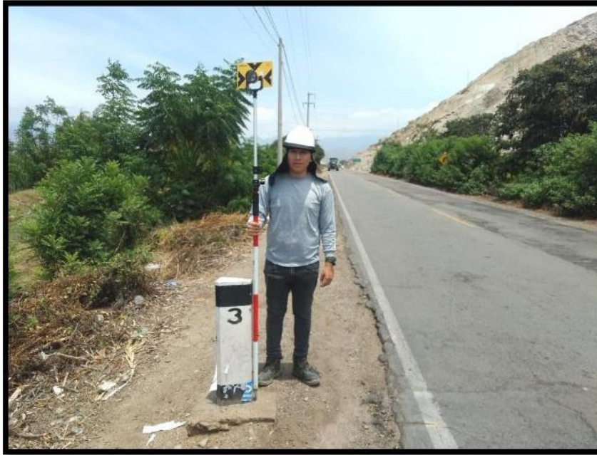
Foto: 07- SE OBSERVA AL TESISTA EN EL KM 3 EN EL FINAL DEL LEVANTAMIENTO TOPOGRAFICO
