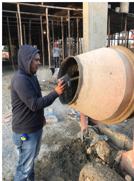
Preparación de concreto con viruta de acero
