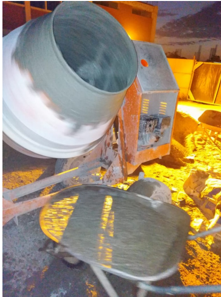
Preparación de concreto convencional, con trompo
