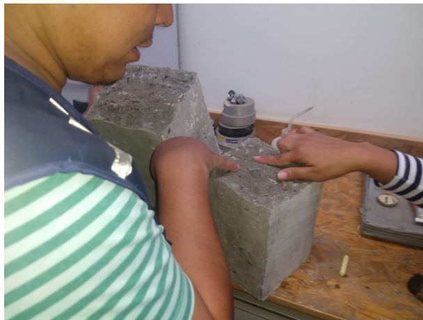
Identificación de viruta de acero en vigas
