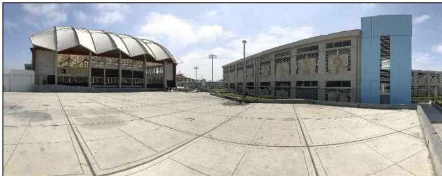
Figura 32 Fachada de la piscina "I.E.E República Argentina"
