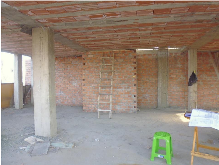
Fuente: Propia, Muros internos en el tercer nivel, considerado como tabiquería.
