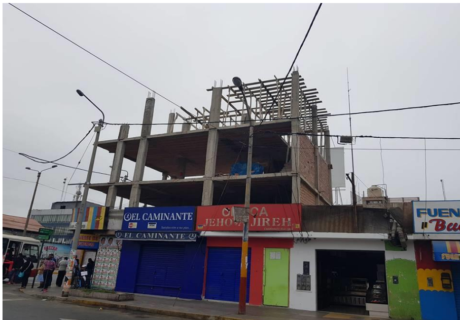
Fuente: Propia, Muro perimetral desfasado entre el nivel 2 y 3 , no replicándose de manera prolongada , comportándose como elemento no estructural.
