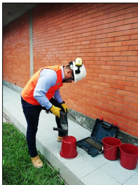
Fotografía 10: Se procedió a perforar pequeños agujeros en la base de las celdas, para que esta manera el agua que se le agregue pueda fluir, y no se sature el sistema.
