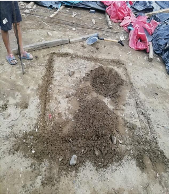
Ubicación y realización de calicata para el estudio de mecánica de suelos.
