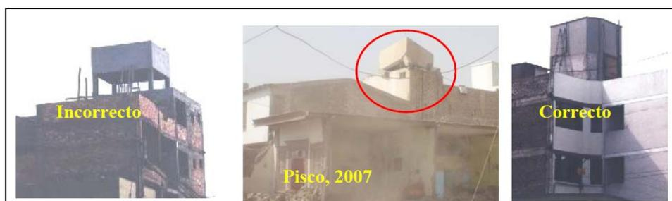
Figura 13. Forma correcta e incorrecta de ubicar la base de un tanque elevado.
