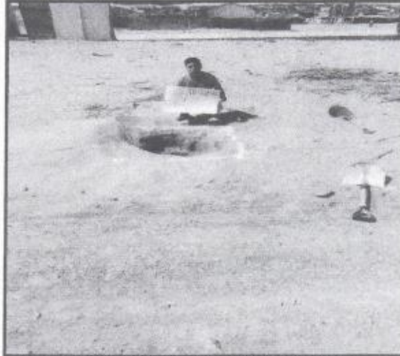
VISTA PANORAMICA DE LA CALICATA N°01
