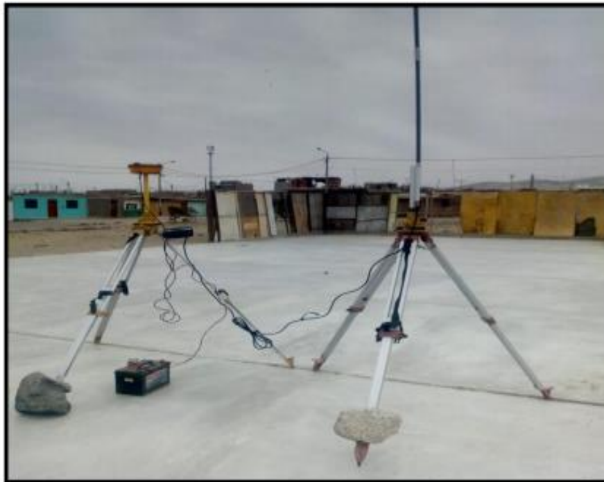
INSTALACION DE BASE GPS DIFERENCIAL
