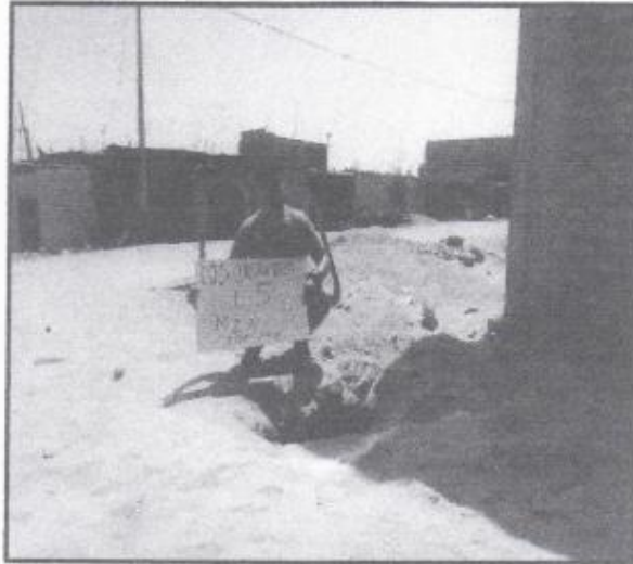
VISTA PANORAMICA DE CALICATA N°05
