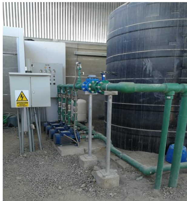
Fotografía. 1 Sistema y equipo de bombeo de la PTAR. Fuente: Elaboración propia.
