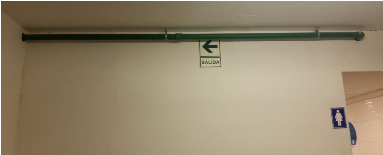
Fotografía. 16 Instalación de red sanitaria de agua tratada en los servicios higiénicos del C.C. El Quinde de Ica. Fuente: Elaboración propia.
