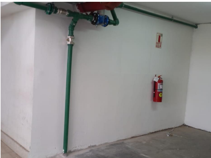
Fotografía. 19 Instalación de red sanitaria de agua tratada en los servicios higiénicos del C.C. El Quinde de Ica. Fuente: Elaboración propia.
