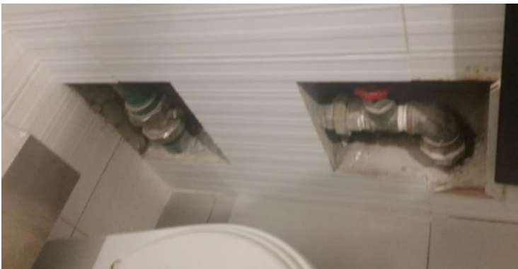
Fotografía. 17 Conexión de la red de agua tratada a los SS.HH del mall, Para los inodoros. Fuente: Elaboración propia.
