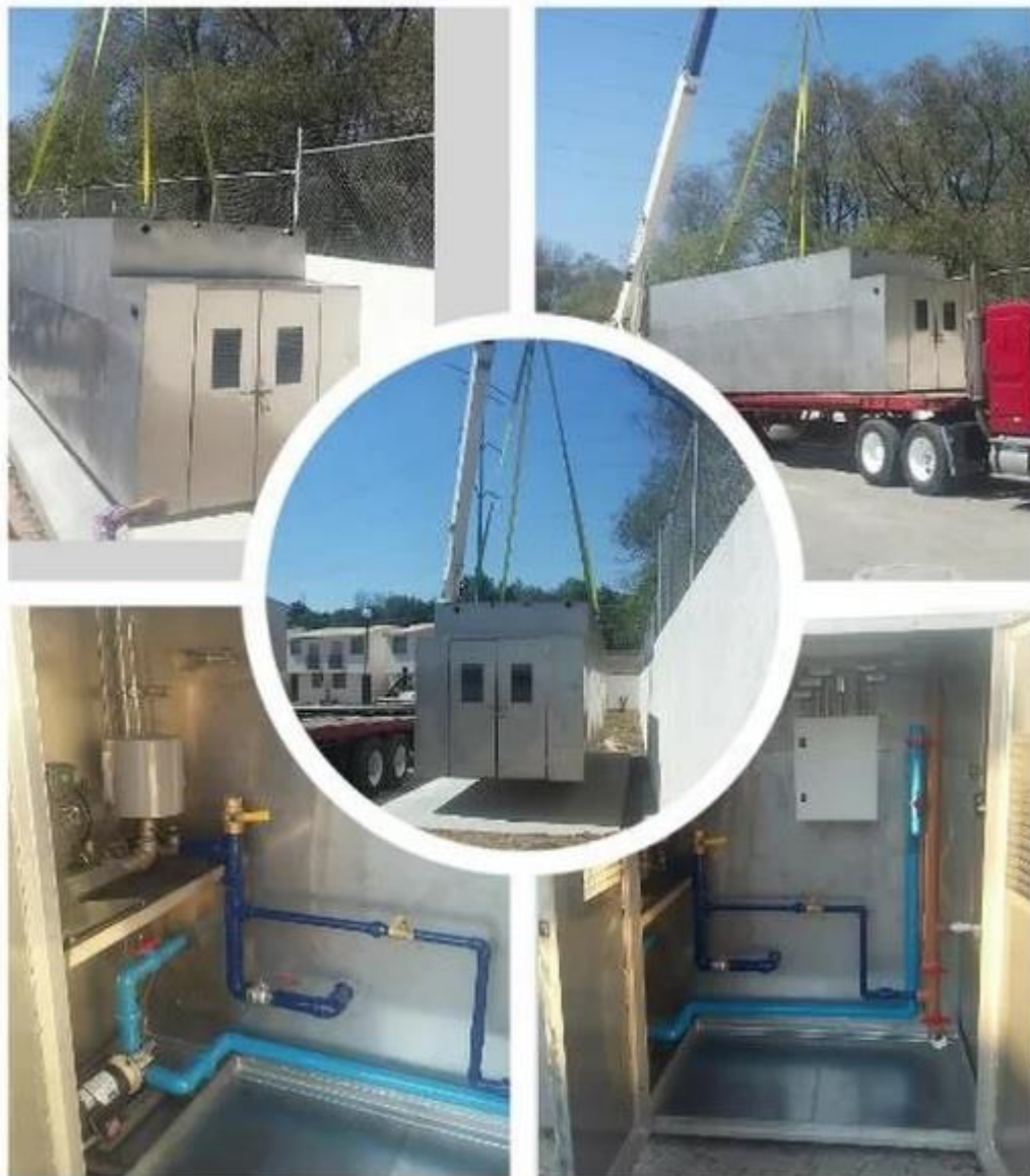
Figura 27. Plantas de tratamiento PAQUETE, movilización y colocación. Fuente: Aclara.mx
