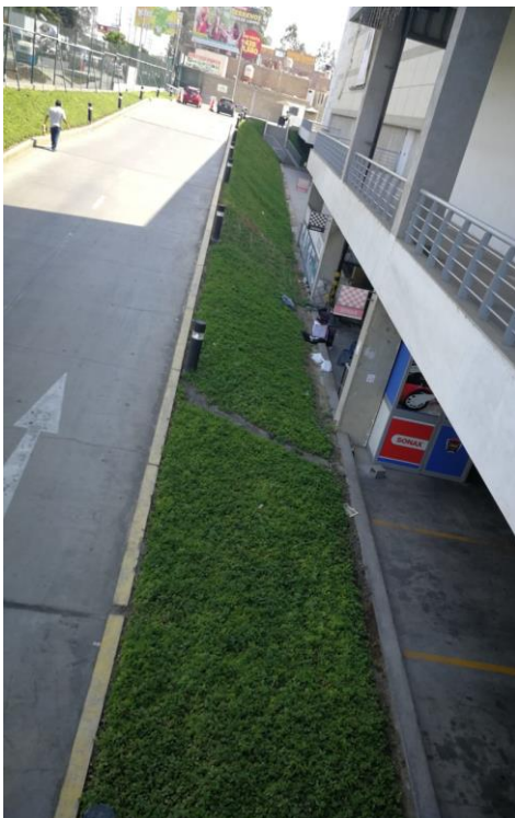
Fotografía. 8 Área verdes en el mall zona 2. Fuente: Elaboración propia.
