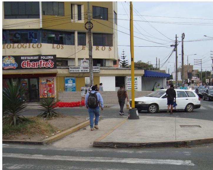
**Figura 48.** Sardineles en aceras deterioradas y desgaste de pintura.
