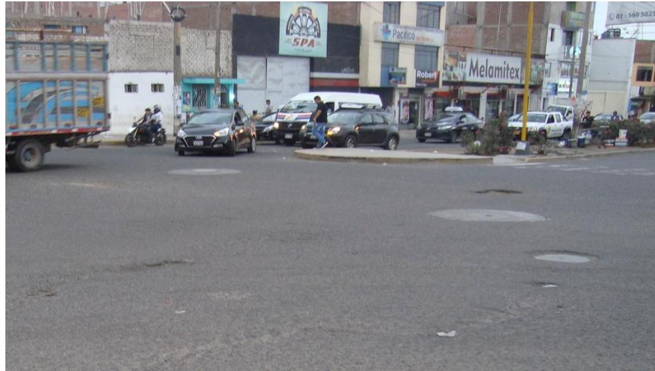
**Figura 49.** Calzada presenta hundimiento en el centro de la intersección.
