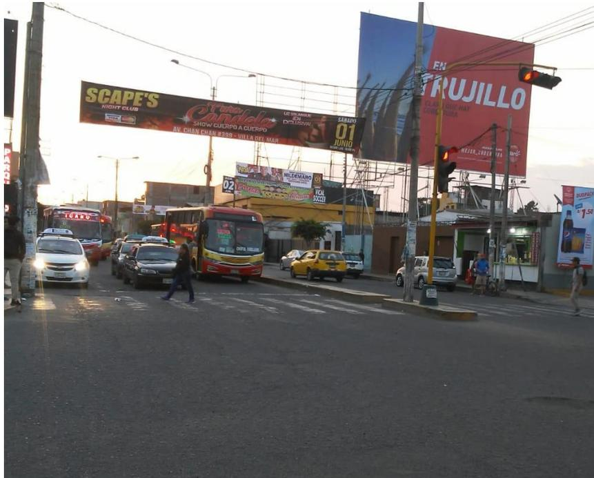
**Figura 35.** Paso de cebra con pintura desgastada.
