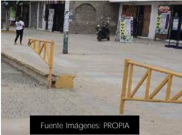
ESTRUCTURA DE ACERO
