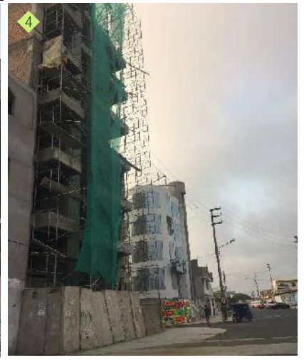
4 EDIFICIO EN CONSTRUCCIÓN Fuente imagen: PROPIA
