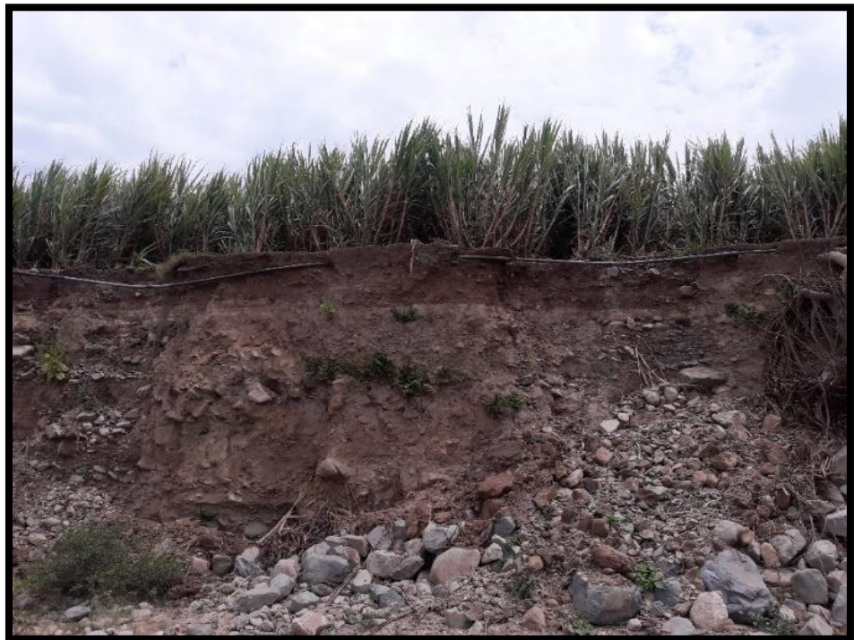
Figura 36: Diferentes tramos de tubería en exposición.
