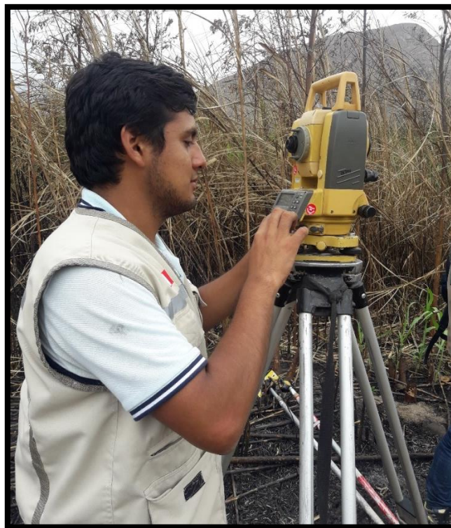
Figura 40: Estacionando y nivelando el equipo topográfico.
