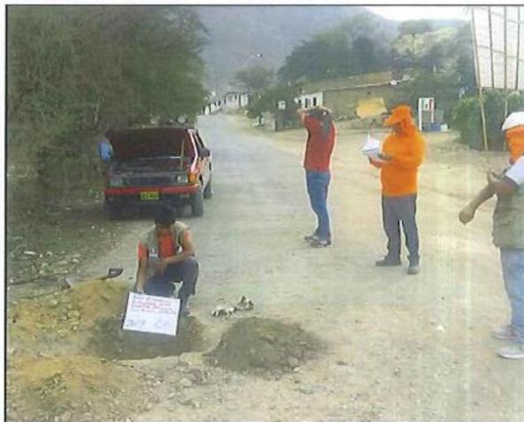
FOTOS 16: SE OBSERVA UNA VISTA PANORÁMICA DE LA EXCAVACION DE LA CALICATA C-08.
