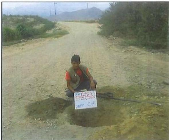
FOTOS 14: SE OBSERVA UNA VISTA PANORÁMICA DE LA EXCAVACION DE LA CALICATA C-07.
