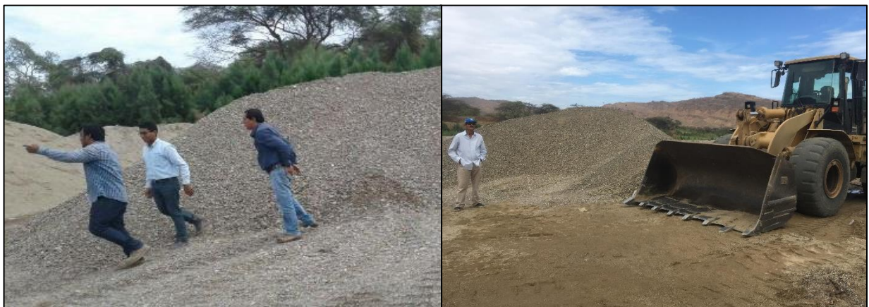
Figura 98. Cantera de Agregados de la Comunidad Campesina de Máncora
