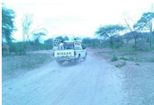
Ilustración 1: tramo de carretera con material de préstamo
