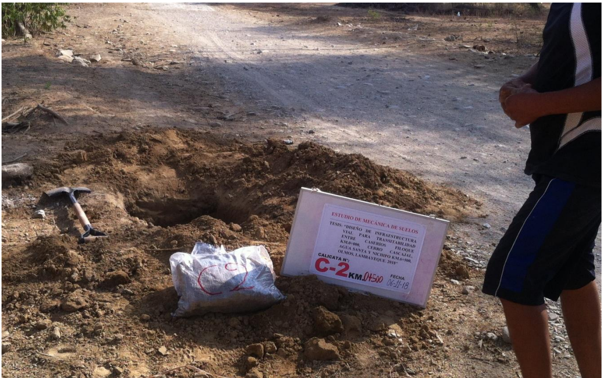
Trabajos de muestras de calicatas
