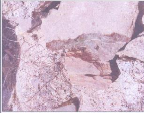
VISTA DE EVALUACION 02 ZONA DE RESERVOIRIO
