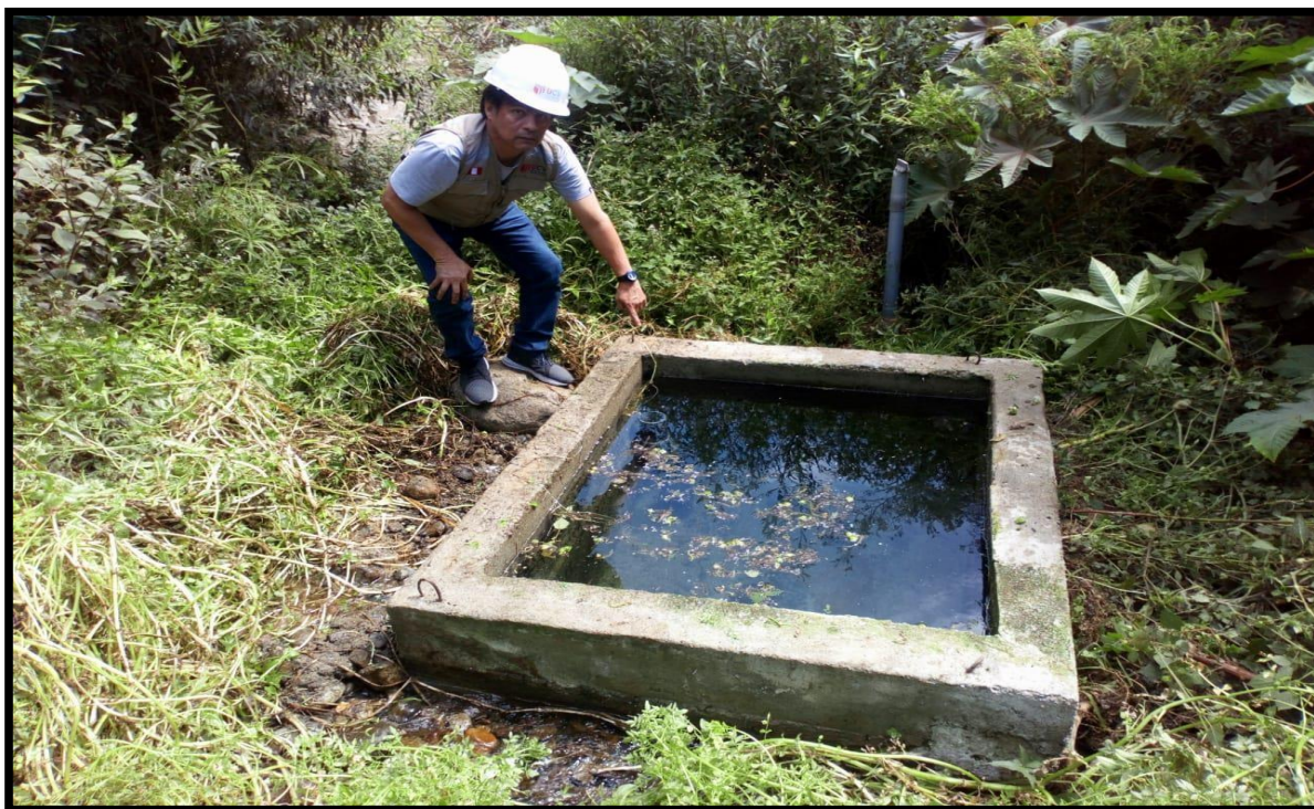
Foto N° 01 Vista de estructura de captación
