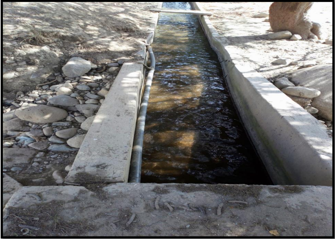
Foto N° 05 Vista de tubería de conducción de PVC expuesta
