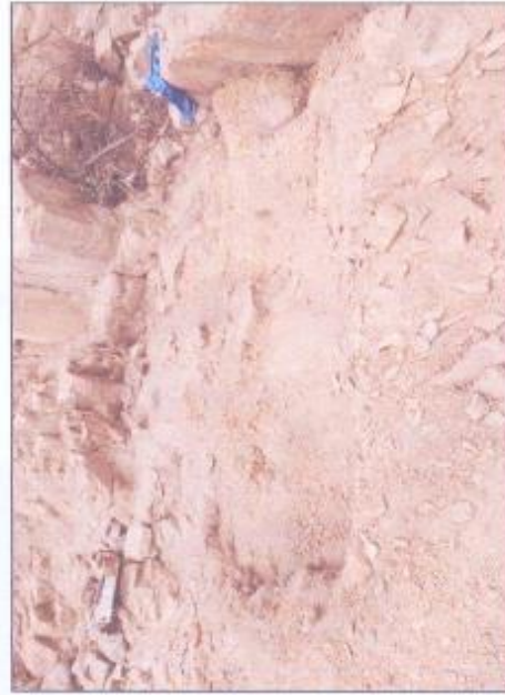
VISTA DE EVALUACIÓN 01 ZONA DE CISTERNA
