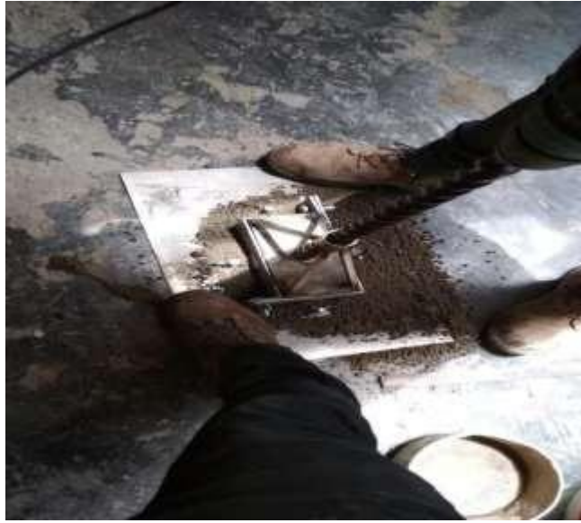
Figura 4. 23. Compactación Experimental de Adoquines
