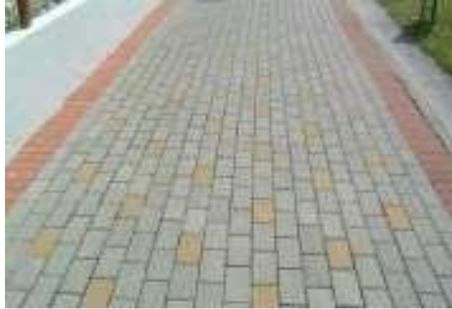
Figura 1. 6. Pavimento Adoquinado
