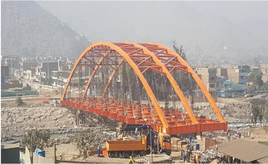
**Figura 2.** Armadura de la Superestructura puente tipo arco. Puente Ñaña – Lima.
