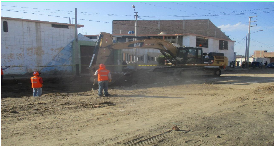
Figura 04: Vista de trabajo de Excavación de Explanada en el sector Cieza de León.
