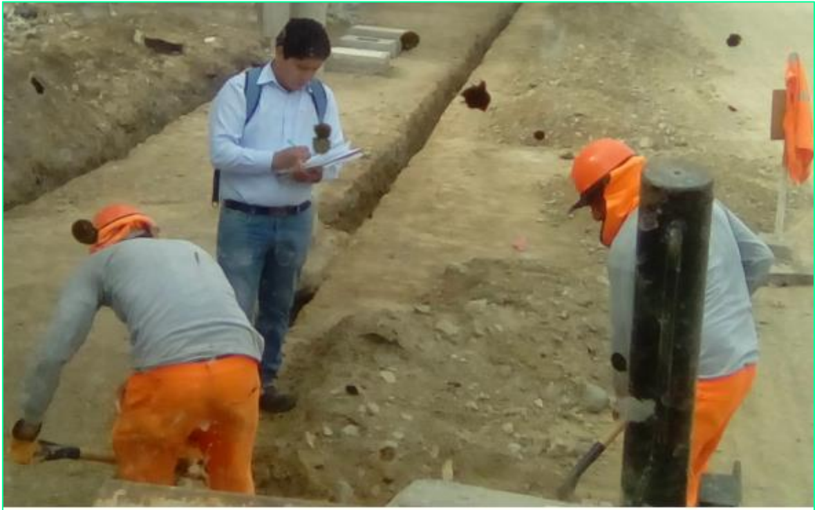
Figura 10: Vista de Toma de datos de la nueva propuesta de cuadrilla según la metodología Lean Construction, como también Se toman datos de la productividad según la herramienta LPDS (TP, TC, TNC) en el Sector Cieza de León.
