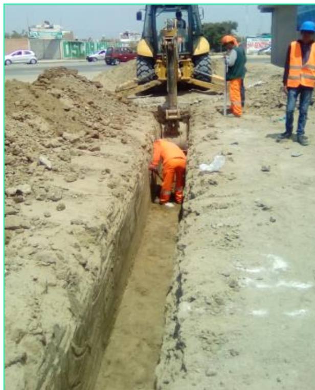
Figura 05: Vista de trabajadores realizando trabajos de Excavación de Zanja con Equipos Hasta 2.5M AF=1.00
