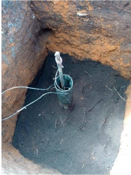
Figura 35. Instalación de la puesta a tierra con cemento conductivo
