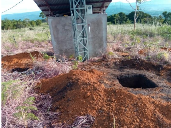
Figura 28. Excavaciones para SPT
