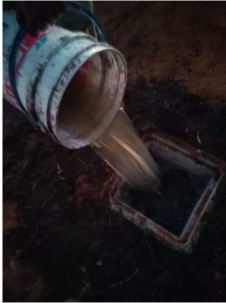
Figura 43. Mezclar el segundo aditivo del Thor-gel
