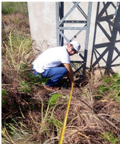
Figura 27. Sacando distancias para las excavaciones
