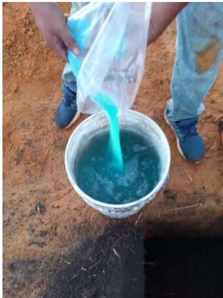
Figura 40. Diluyendo el primer aditivo del Thor-gel
