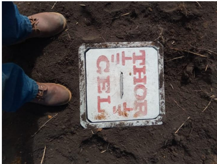
Figura 36. Puesta a tierra terminada con cemento conductivo
