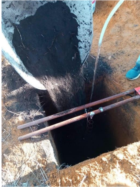
Figura 39. Atestar con tierra vegetal unos 70cm de altura con bastante agua
