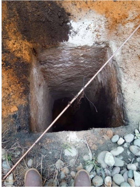
Figura 31. Haciendo el primer procedimiento de la puesta a tierra con bentonita
