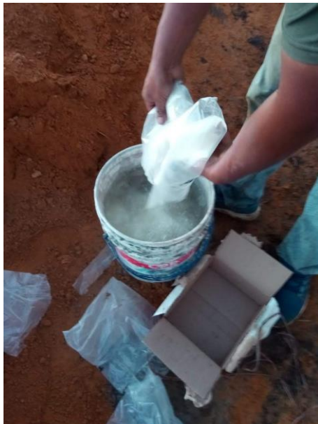
Figura 42. Diluyendo el segundo aditivo del Thor-gel
