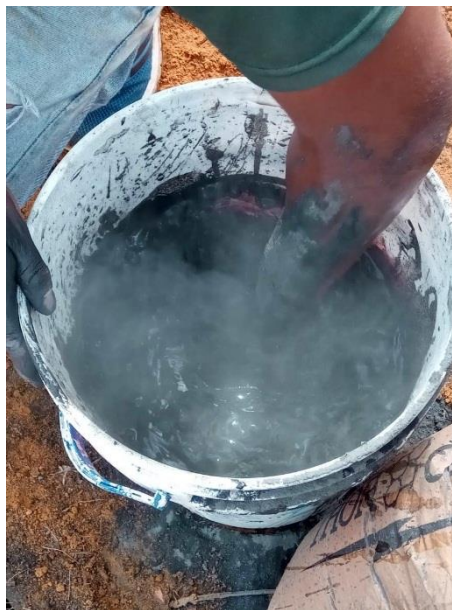
Figura 34. Preparación del cemento conductivo
