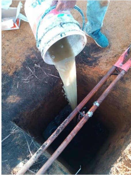
Figura 41. Mezclar el primer aditivo del Thor-gel
