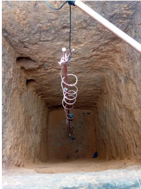
Figura 29. Presentación de la jabalina de cobre para el trabajo de puesta a tierra con bentonita
