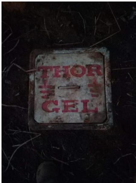
Figura 44. Puesta a tierra terminada con Thor-gel
