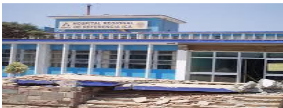
Figura 1. Atención de emergencias en carpas debido al sismo del 2007
