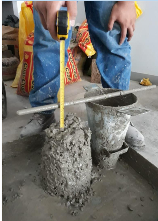
ANEXO 12 Prueba del Slump antes del llenado a los moldes de flexión.
