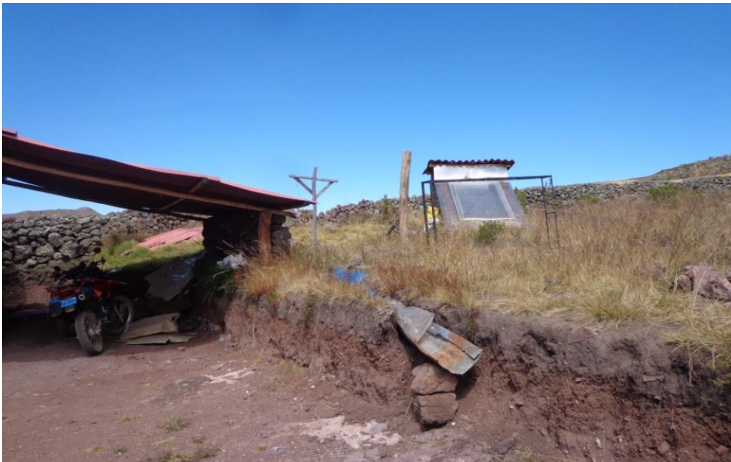
Paneles solares como fuente de energía para el puesto de control Auguinatate
