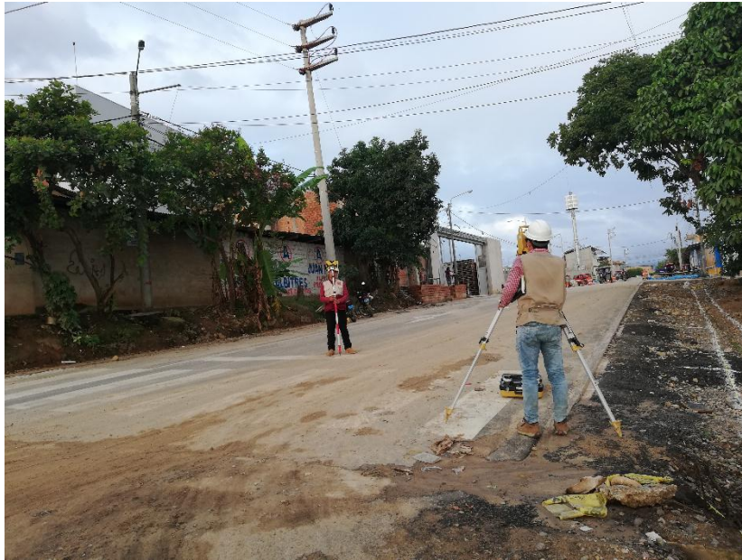
Barriando puntos con la Estación total marca TOPCON, parte posterior del Supermercados Plaza Veá. Jr. Francisco Pizarro c-08
