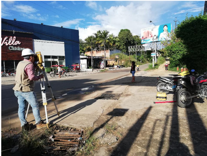
Barriendo puntos con la Estación total marca TOPCON, frontis de la discoteca Anaconda – Morales
