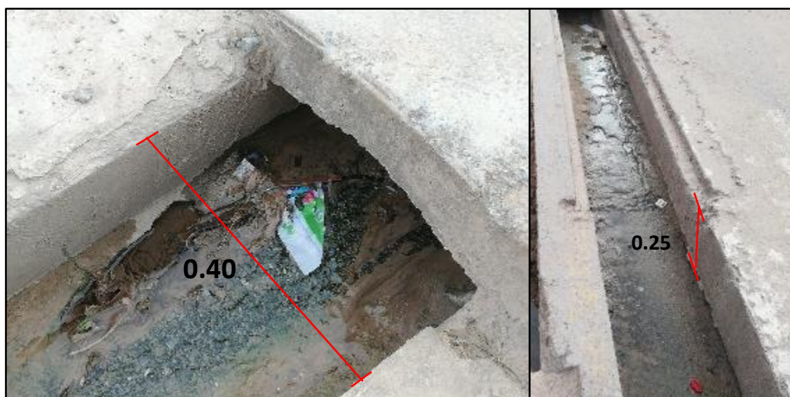
Figura 45. Medida de cuneta en la progresiva 0+400 de Oeste a Este
