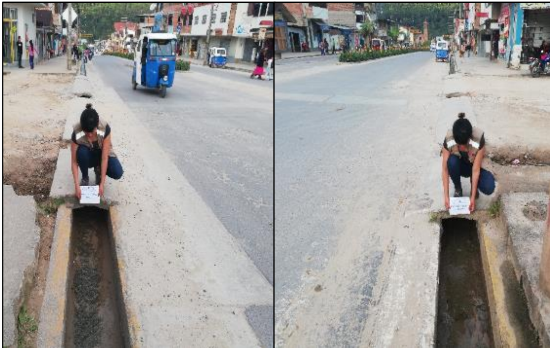
Figura 47. Inspección visual de cuneta en la progresiva 0+500
