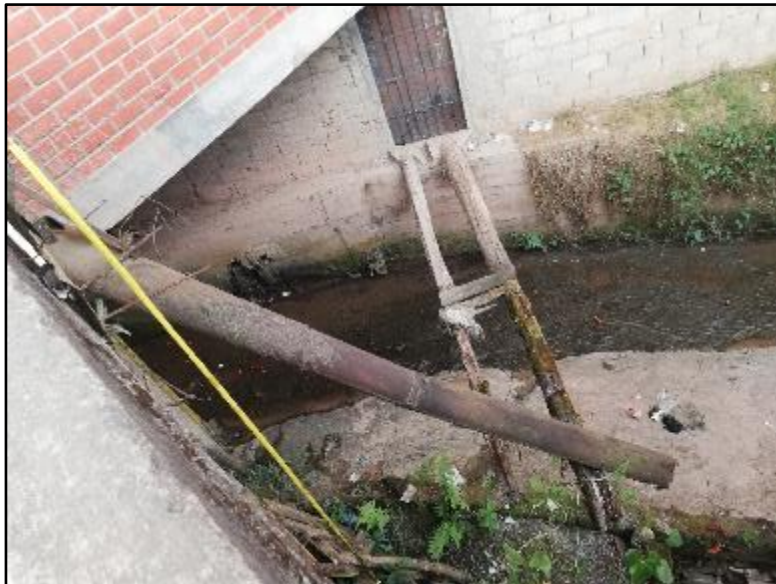
Figura 61. Inspección visual de alcantarilla
