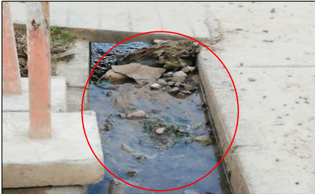
Figura 56. Progresiva 0+200 de Este a Oeste
