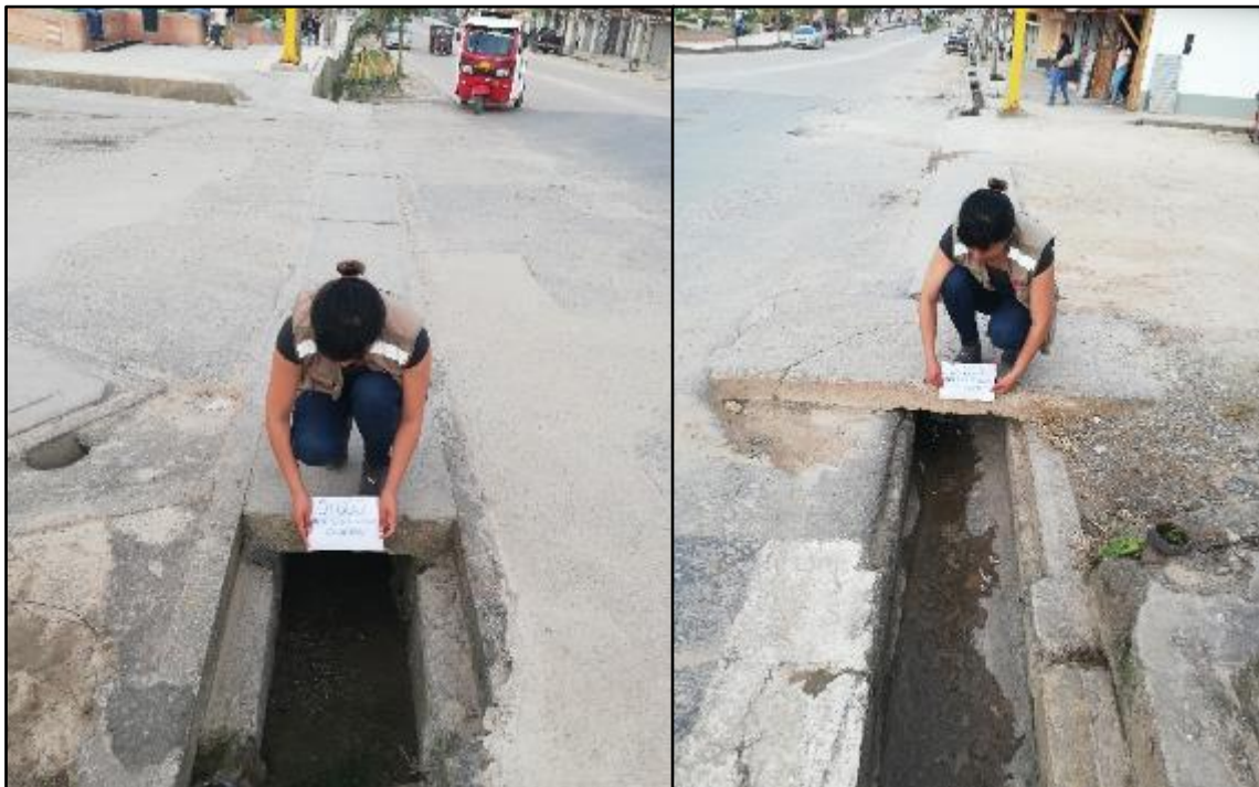
Figura 49. Inspección visual de cuneta en la progresiva 0+600
