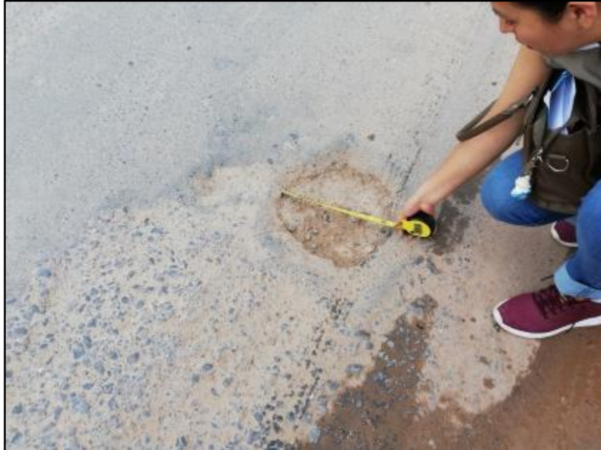
Figura 13. Progresiva 0+000 a 0+100 de Este a Oeste Fuente: Propia
