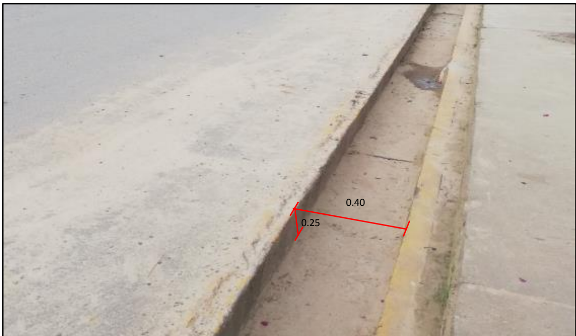
Figura 42. Medida de cuneta en la progresiva 0+300 de Oeste a Este
