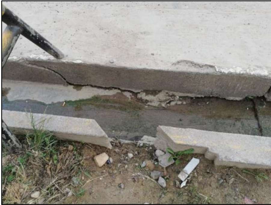
Figura 59. Progresiva 0+400 de Oeste a Este
