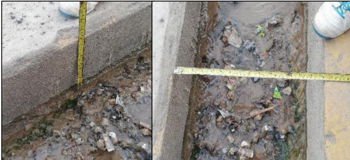
Figura 48. Medida de cuneta en la progresiva 0+500 de Este a Oeste
