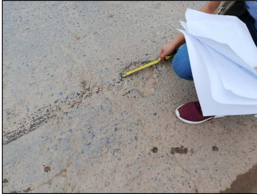
Figura 12. Progresiva 0+000 a 0+100 de Este a Oeste Fuente: Propia
