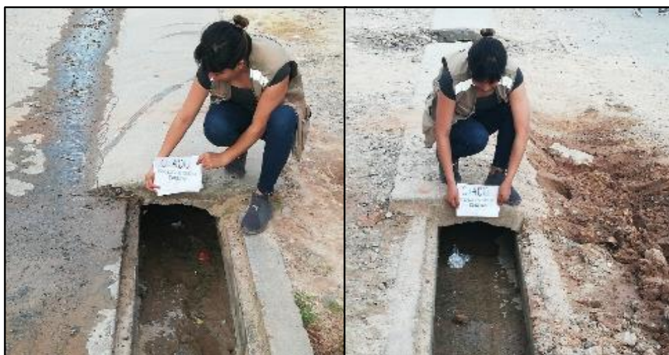
Figura 44. Inspección visual de cuneta en la progresiva 0+400
