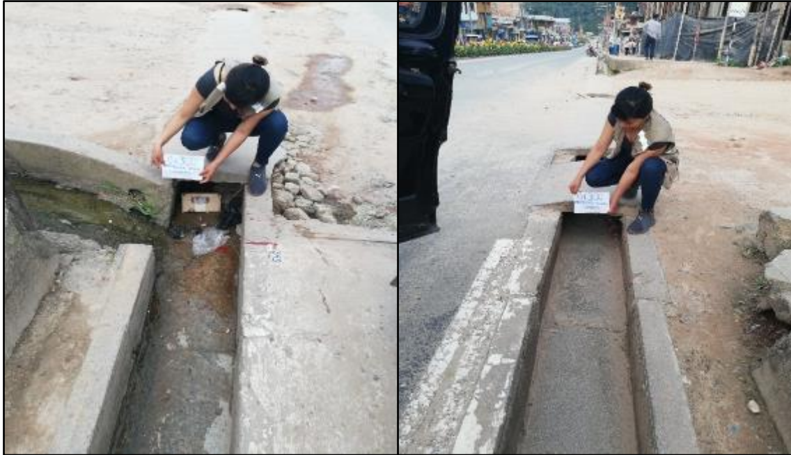
Figura 41. Inspección visual de cuneta en la progresiva 0+300
