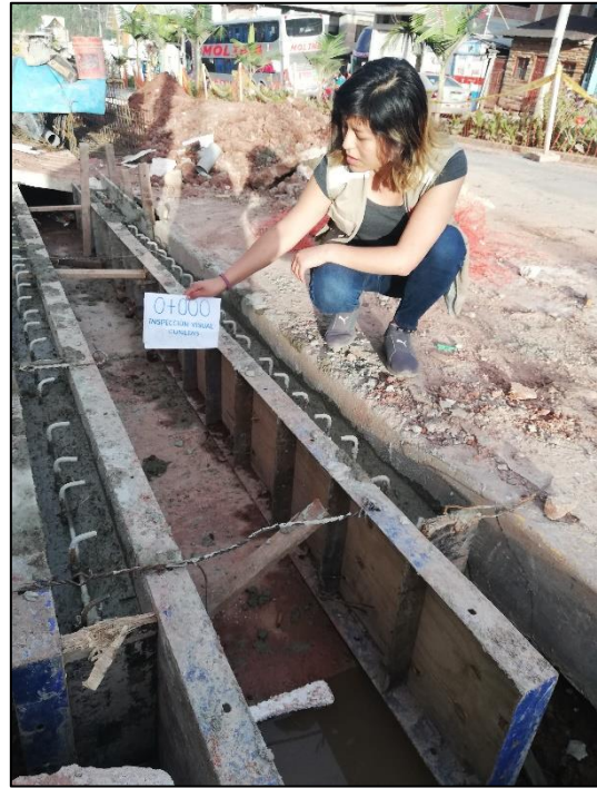
Fotografía 2. Inspección visual de cuneta
