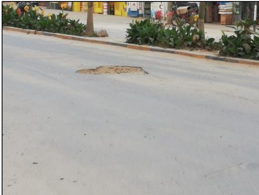
Figura 15. Progresiva 0+200 a 0+300 de Oeste a Este Fuente: Propia
