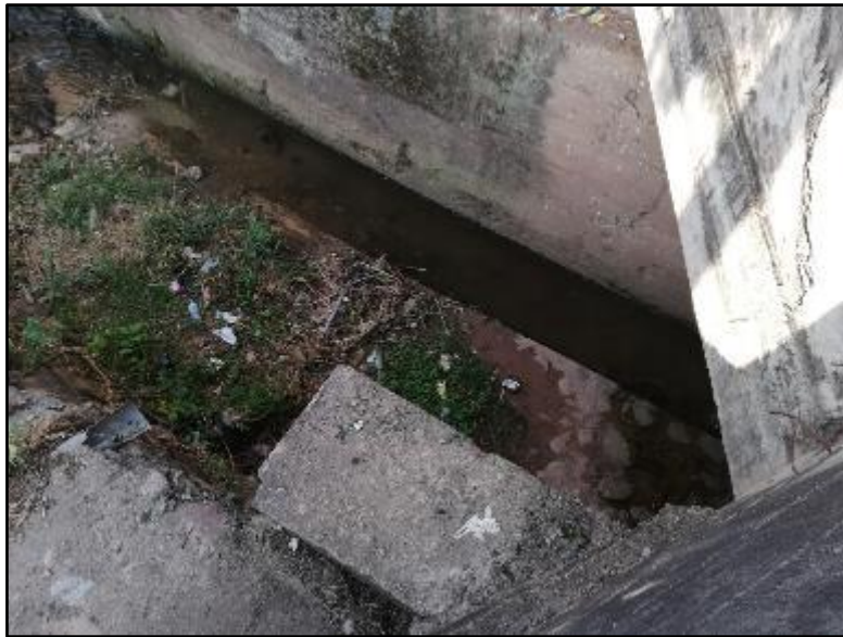
Figura 60. Inspección visual de alcantarilla
