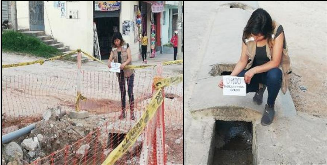
Figura 35. Progresiva 0+100 de Este a Oeste
