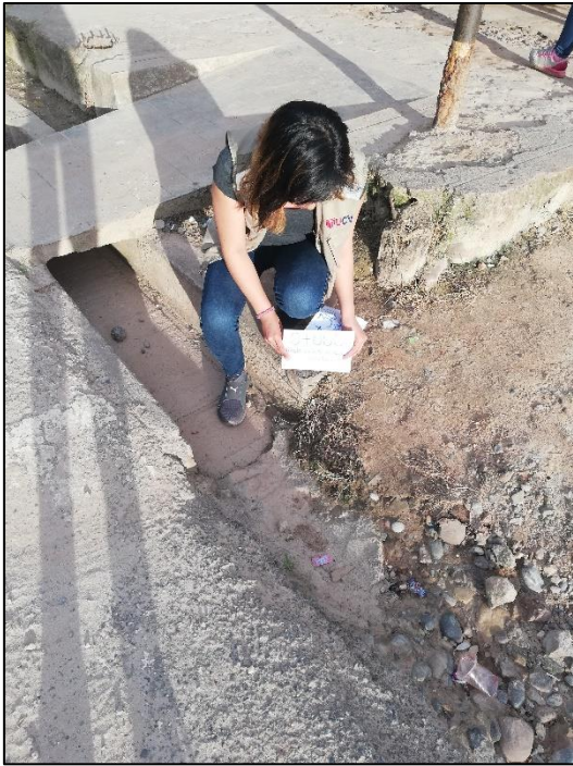
Fotografía 1. Inspección visual de cuneta
