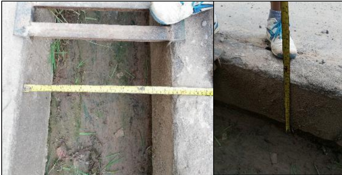
Figura 37. Progresiva 0+100 de Este a Oeste
