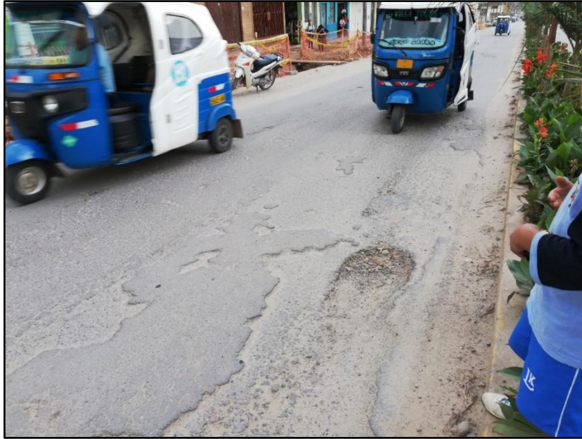
Figura 14. Progresiva 0+000 a 0+100 de Este a Oeste Fuente: Propia
