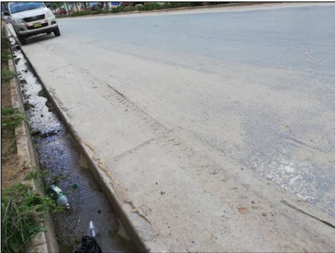
Figura 31. Inspección visual de cuneta
