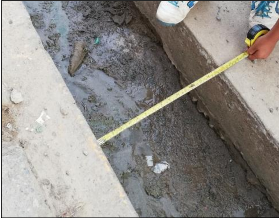
Figura 43. Medida de cuneta en la progresiva 0+300 de Este a Oeste
