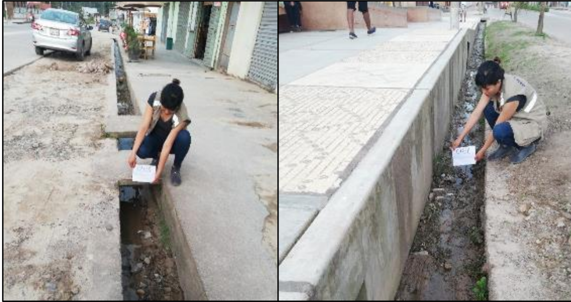
Figura 50. Inspección visual de cuneta en la progresiva 0+680.91
