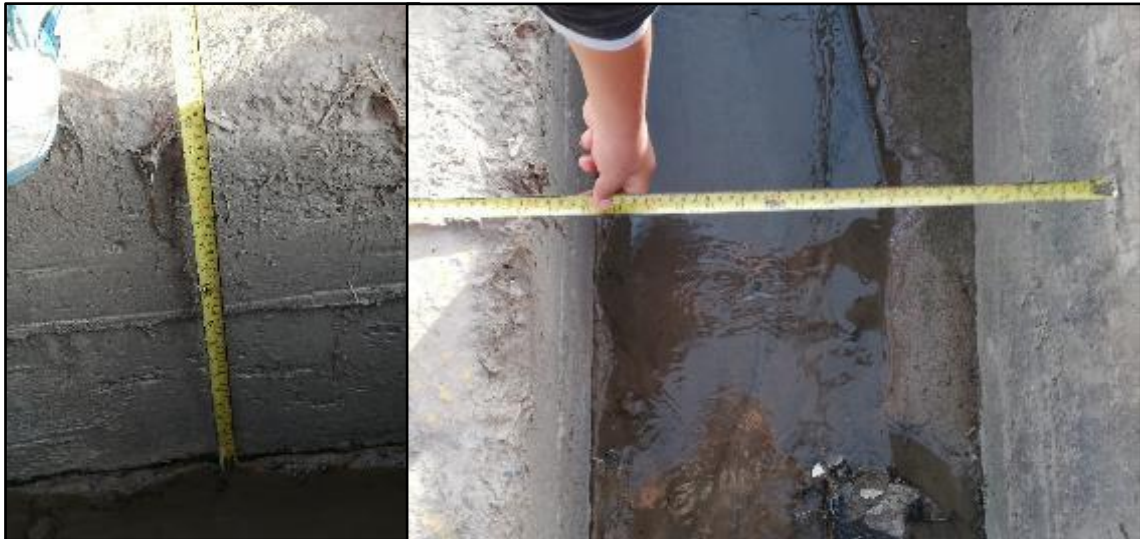
Figura 52. Medida de cuneta en la progresiva 0+600 a 0+680.91 de Este a Oeste
