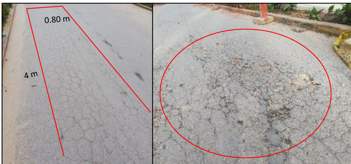
Figura 11. Progresiva 0+000 a 0+100 de Oeste a Este y de Este a Oeste Fuente: Propia
