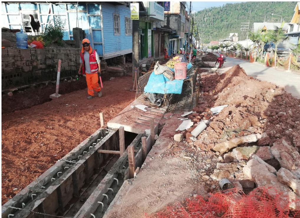
Fotografía 3. Inspección visual de cuneta
