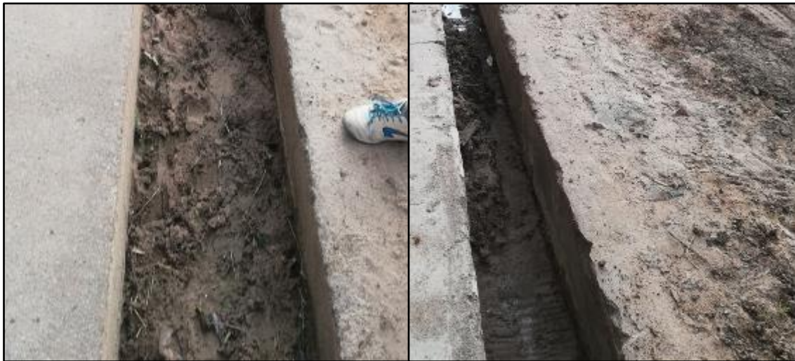
Figura 51. Medida de cuneta en la progresiva 0+600 y 0+680.91 de Oeste a Este
