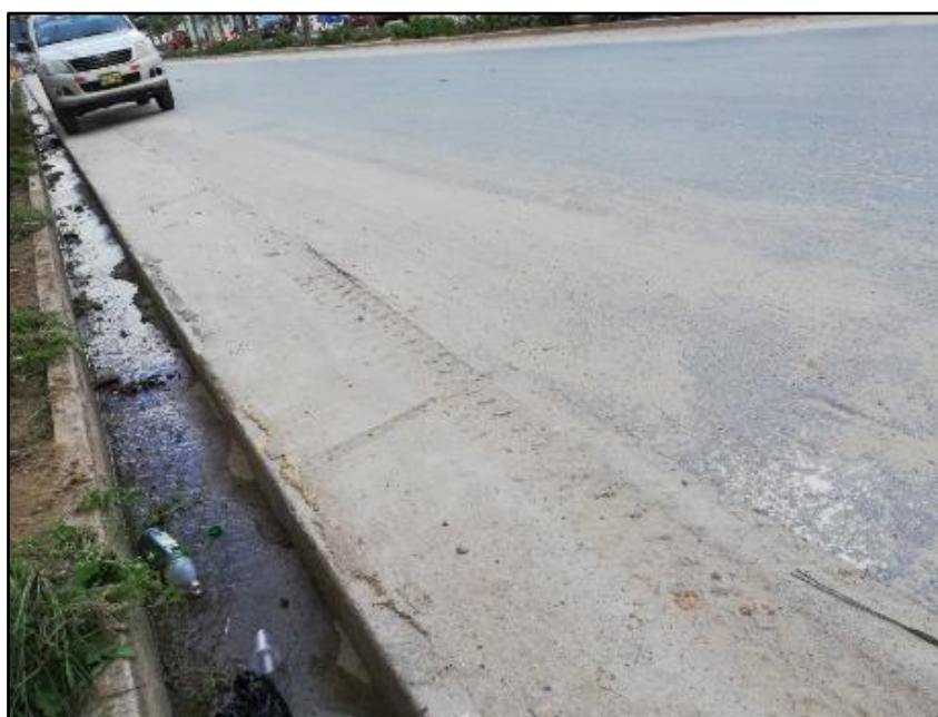
Figura 68. Inspección visual de cuneta
