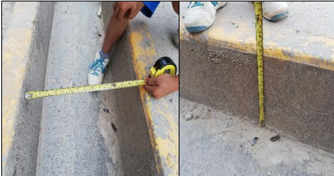
Figura 39. Medida de cuneta de la progresiva 0+200 de Oeste a Este
