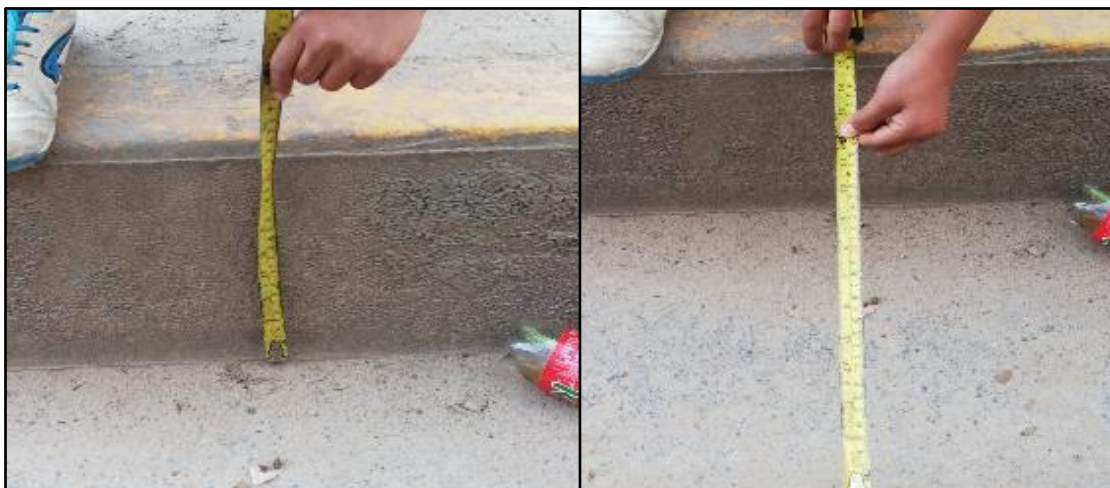
Figura 40. Medida de cuneta en la progresiva 0+200 de Este a Oeste
