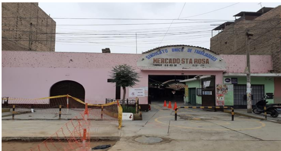
Entrada principal del Mercado Sta. Rosa. Jr. Loreto 3575
