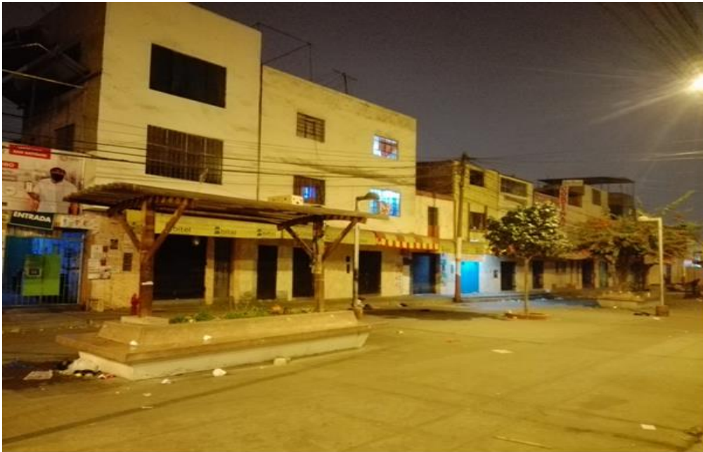
Entrada principal del Mercado San Antonio.
