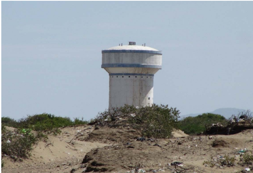
Centro Poblado Túpac Amaru. Tanque de agua potable sin terminar. Fotografía del autor.
