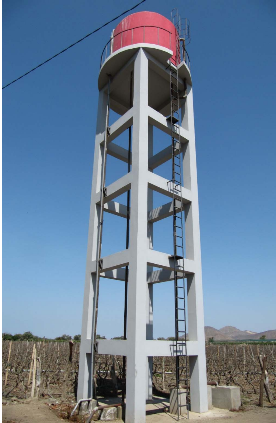
Caserío El Progreso, Tanque de agua potable sin terminar. Fotografía del autor.
