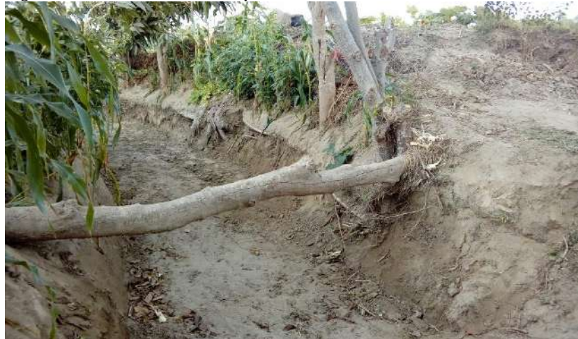
Figura 7. Se observa retención y erosión de los taludes de canal.
