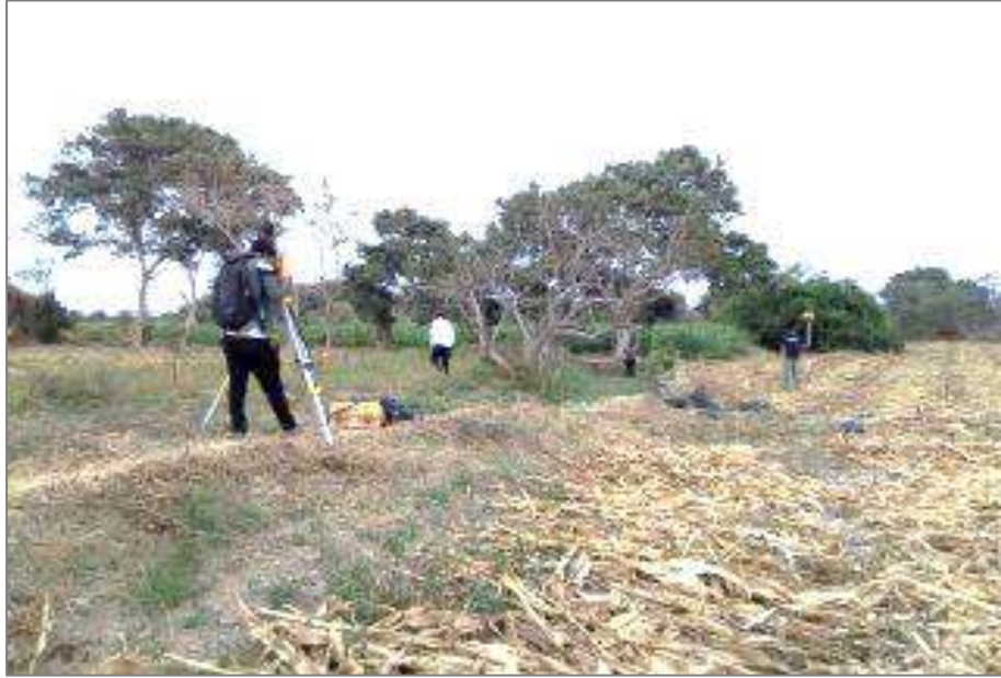
Fotografía Nª 05: Levantamiento topográfico del canal Annape, km. 1+200.
