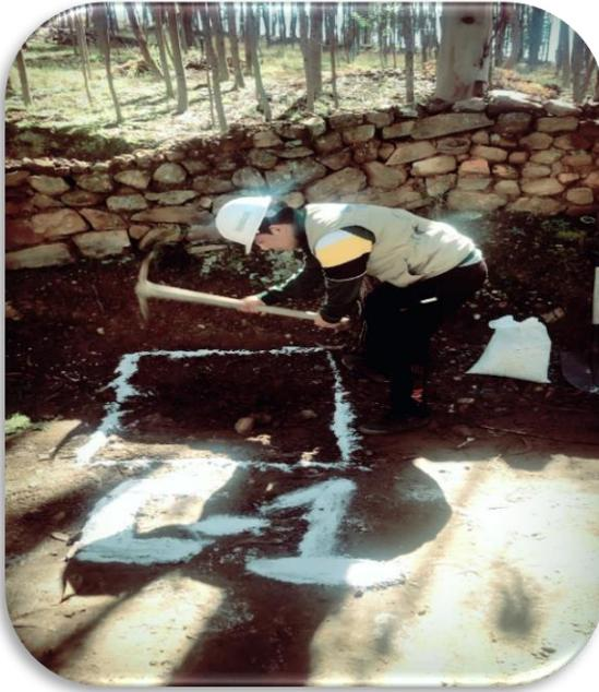
Figura 28. Excavación de la calicata 01
