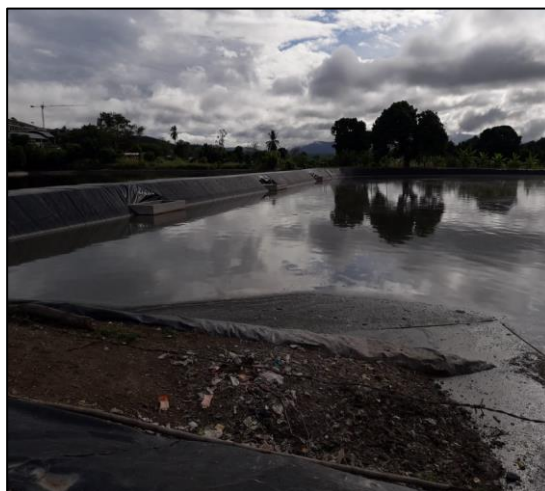
Lagunas de estabilización nueva
