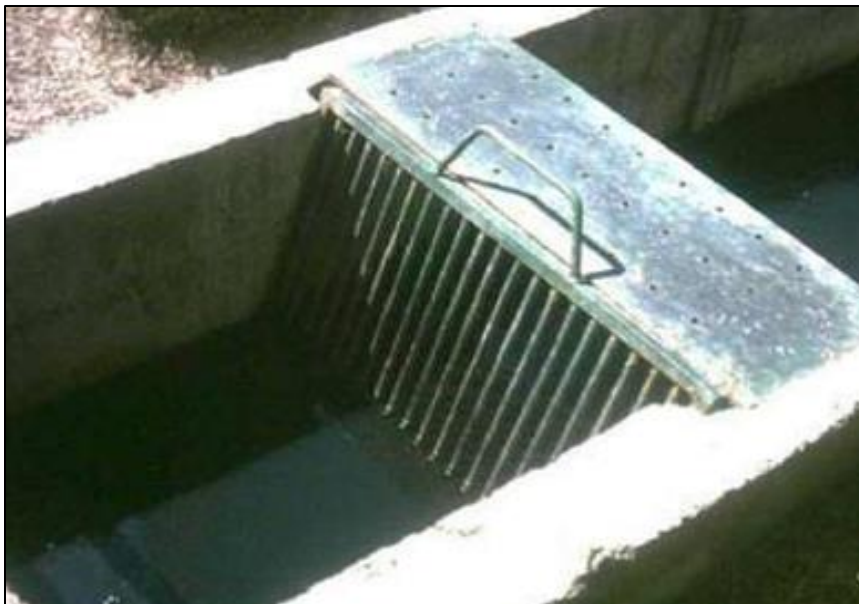
Figura 7. Rejillas de desbaste
