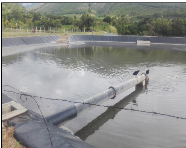
Lagunas de estabilización nueva
