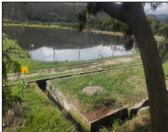
Ingreso del afluente a las lagunas de estabilización
