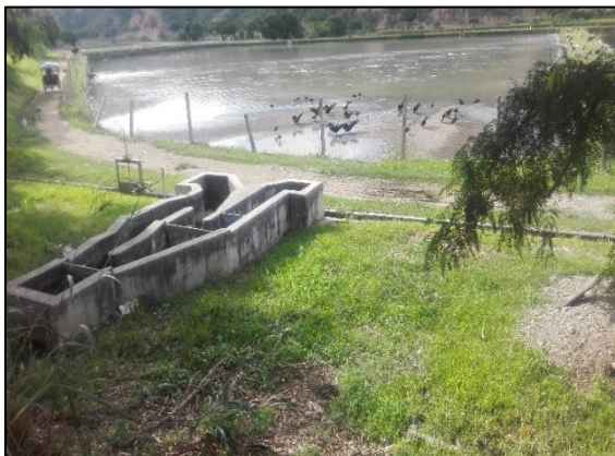
Cámara de rejas antigua
