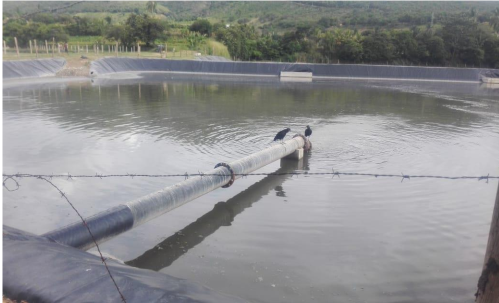
Figura 13. Laguna de estabilización de la ciudad de Jaén.
