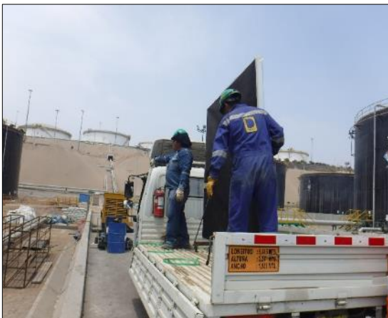
Fuente: Elaboración propia Figura 13. Instalación de la Barrera Acústica en Cubeto del Tanque N°6.
