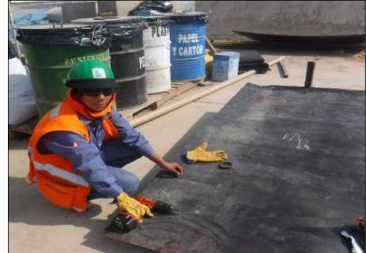
Fuente: Elaboración propia Figura 21. Colocación de la Geomembrana en la Barrera Verde.
