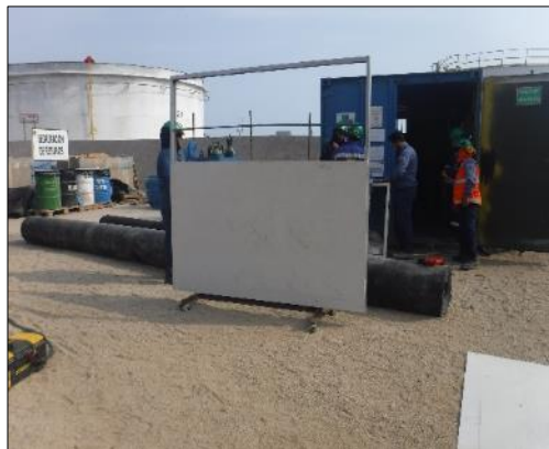
Fuente: Elaboración propia Figura 19. Colocación del fibrocemento en la Barrera Verde.
