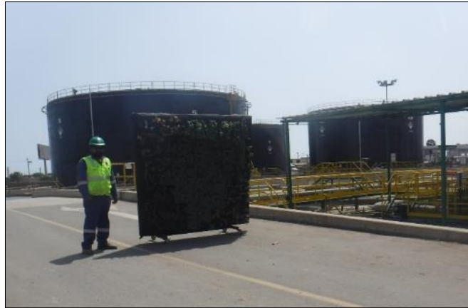
Fuente: Elaboración propia Figura 23. Colocación de la cubierta vegetal.
