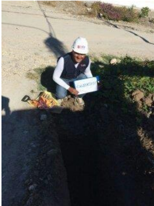
Extracción de la calicata 02
