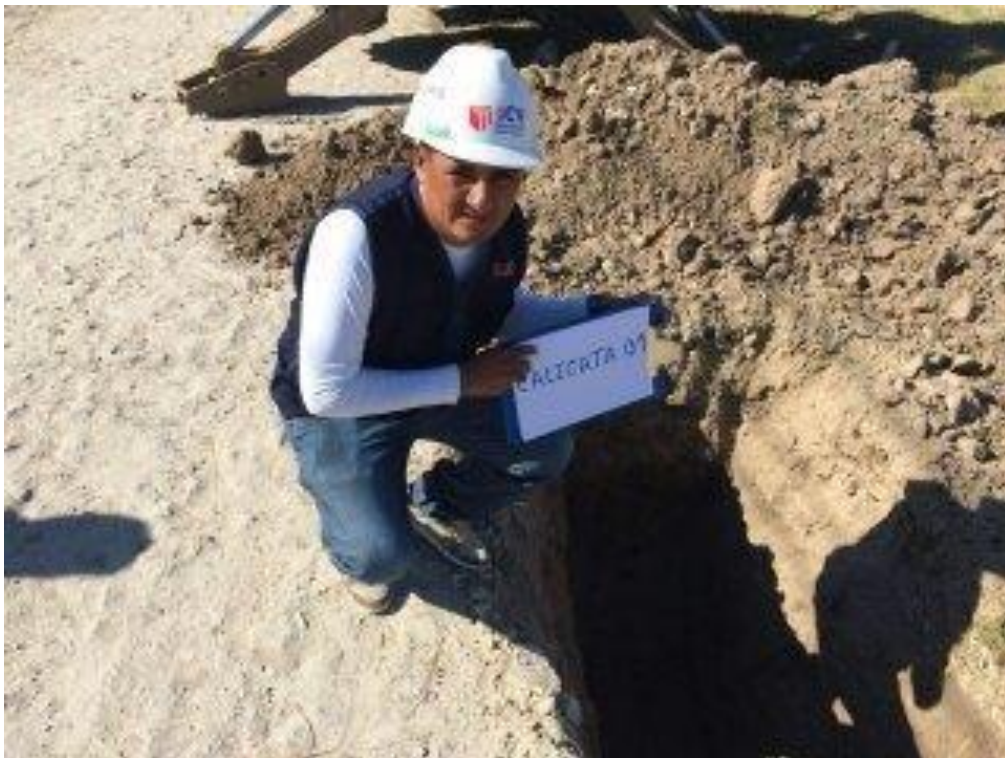
Extracción de la calicata 01
