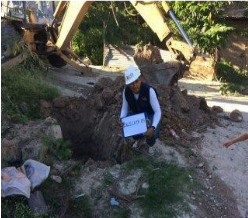
Extracción de la calicata 04
