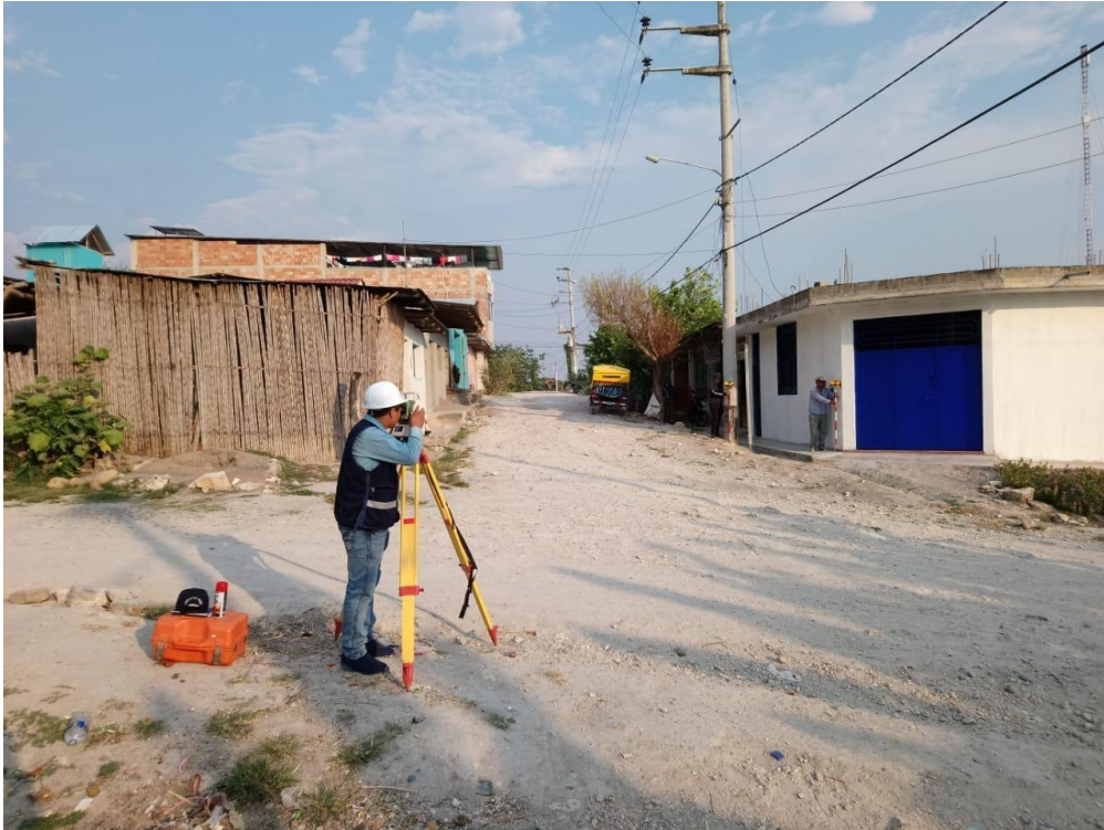
Realizando el levantamiento topográfico de la zona
