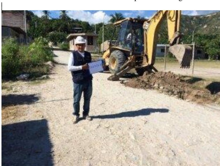
Figura 3. Excavación de calicatas, con la ayuda de maquinaria.
