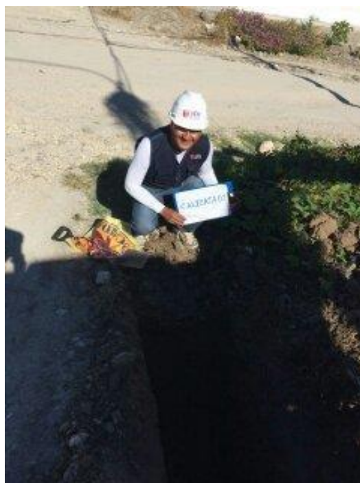
Figura 5. Extracción de material para CBR, calicata 2.
