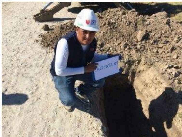
Figura 4. Extracción de material de la calicata 1.
