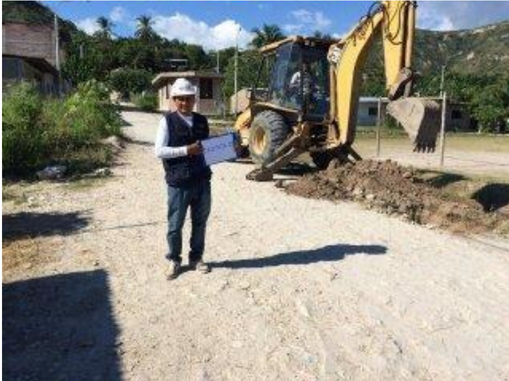
Extracción de la calicata con maquinaria
