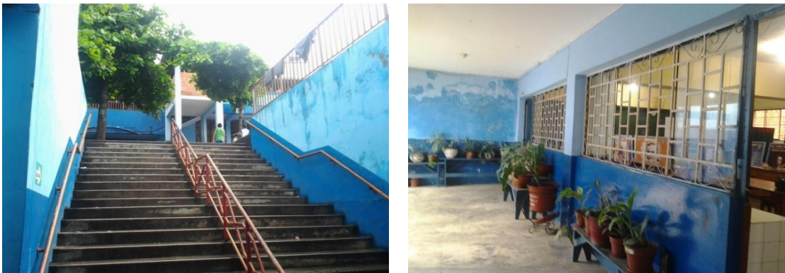
Figura 16: Foto de la escalera al laboratorio químico
