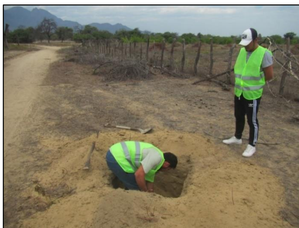
Figura 4. Excavando las calicatas en la zona
