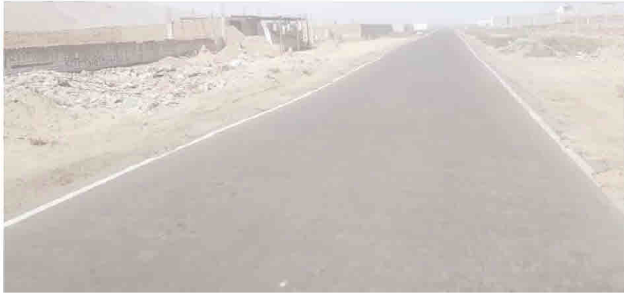
Figura 28. Unidad de inspección U – 075 ubicada entre los 2 + 516 KM – 2 + 550 KM de la carretera Huanchaco – Santiago de Cao
