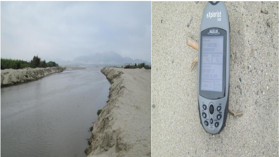
Imagen N°04: Primer punto vulnerable a desborde del Rio Lacramarca.
