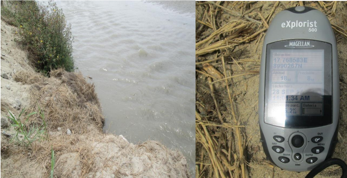
Imagen N°05: Segundo punto vulnerable a desborde del Rio Lacramarca.
