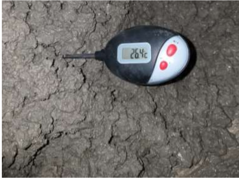
Figura 07: Temperatura del concreto
