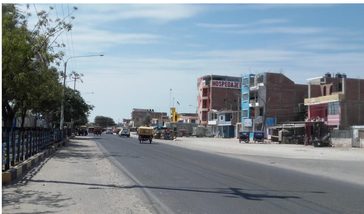
Av. Bayóvar- Margen derecho - Sechura
